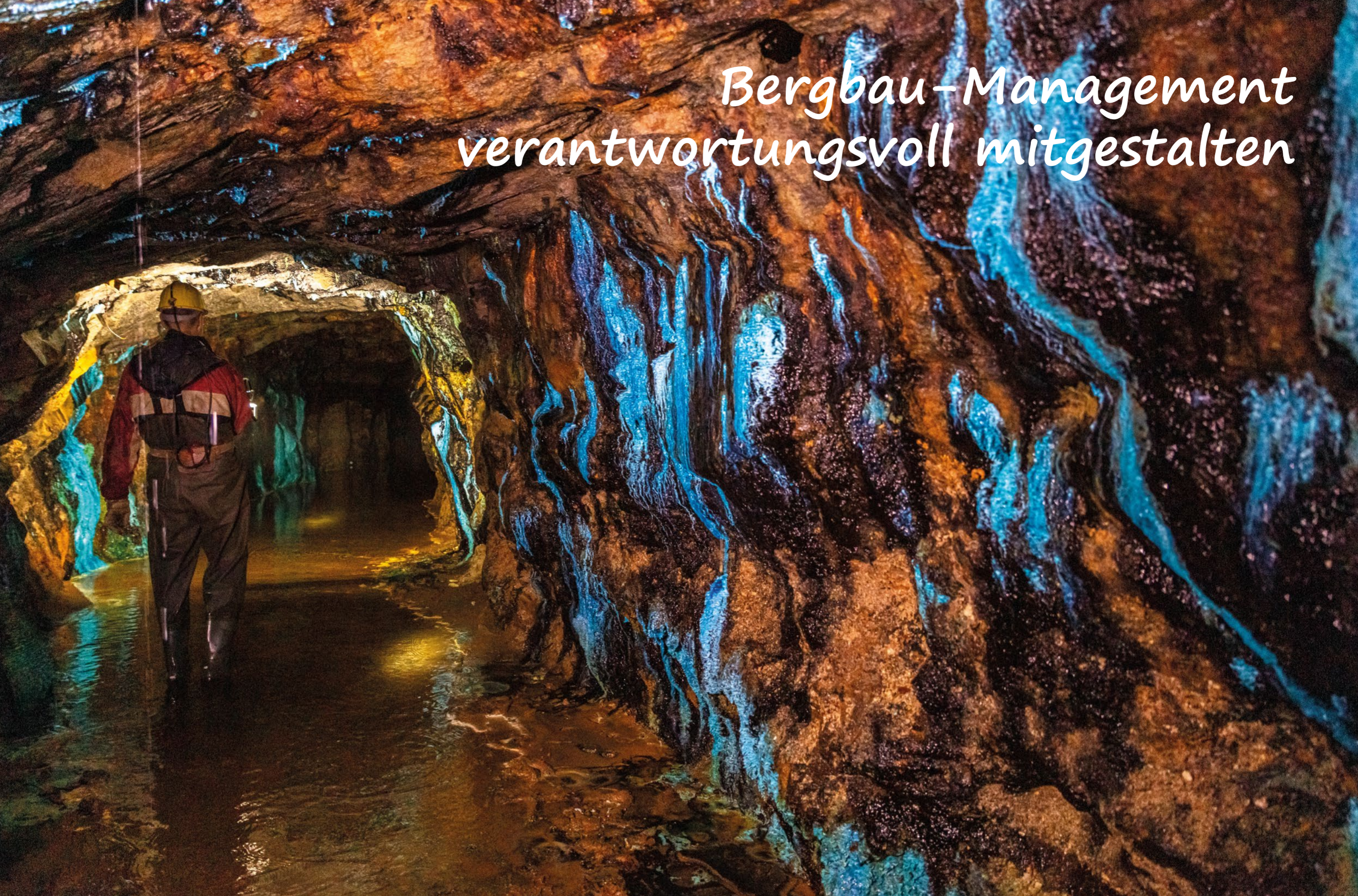
Wir prognostizieren bei Eingriffen in den Untergrund die Auswirkungen auf das unterirdische Wasser – Rothschnöberger Stolln zur Entwässerung des Grubenreviers Freiberg.
