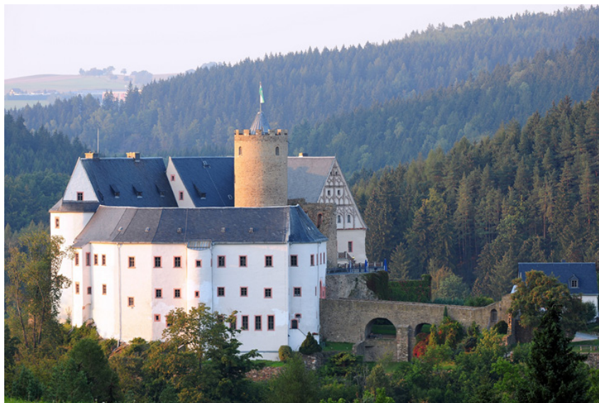
Bild 2 Burg Scharfenstein (© Lutz Zimmermann)
