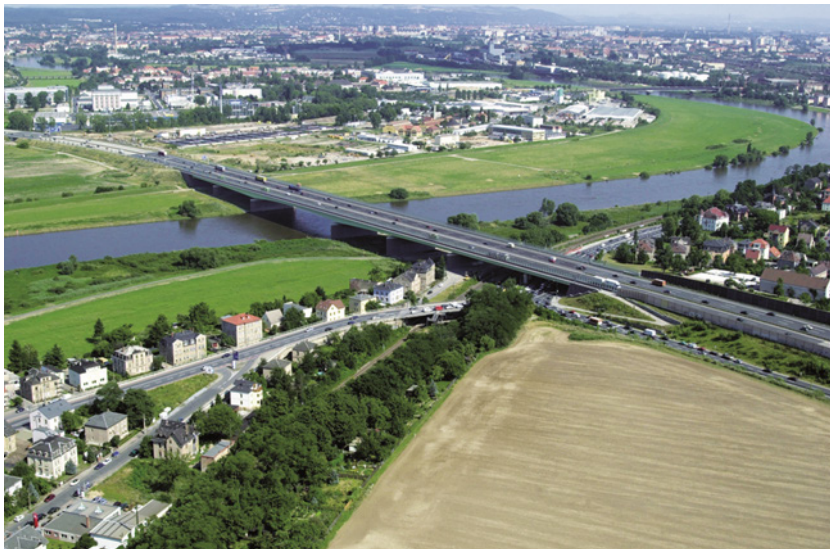
Bild 11 Erweiterung A 4 VDE, Ersatzneubau Elbebrücke in Dresden (© DEGES)
