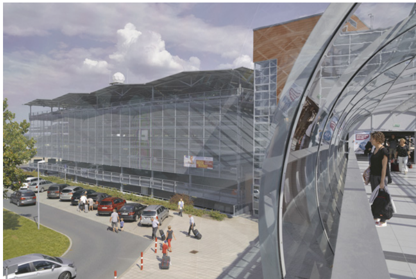
Bild 27 Parkhaus, Vorfahrt mit Kurzzeitparkplätzen, Skywalk (© Flughafen Dresden GmbH, Michael Weimer)
