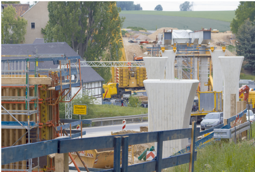
Bild 25 Brückenbau Ottendorf (© LISt)
