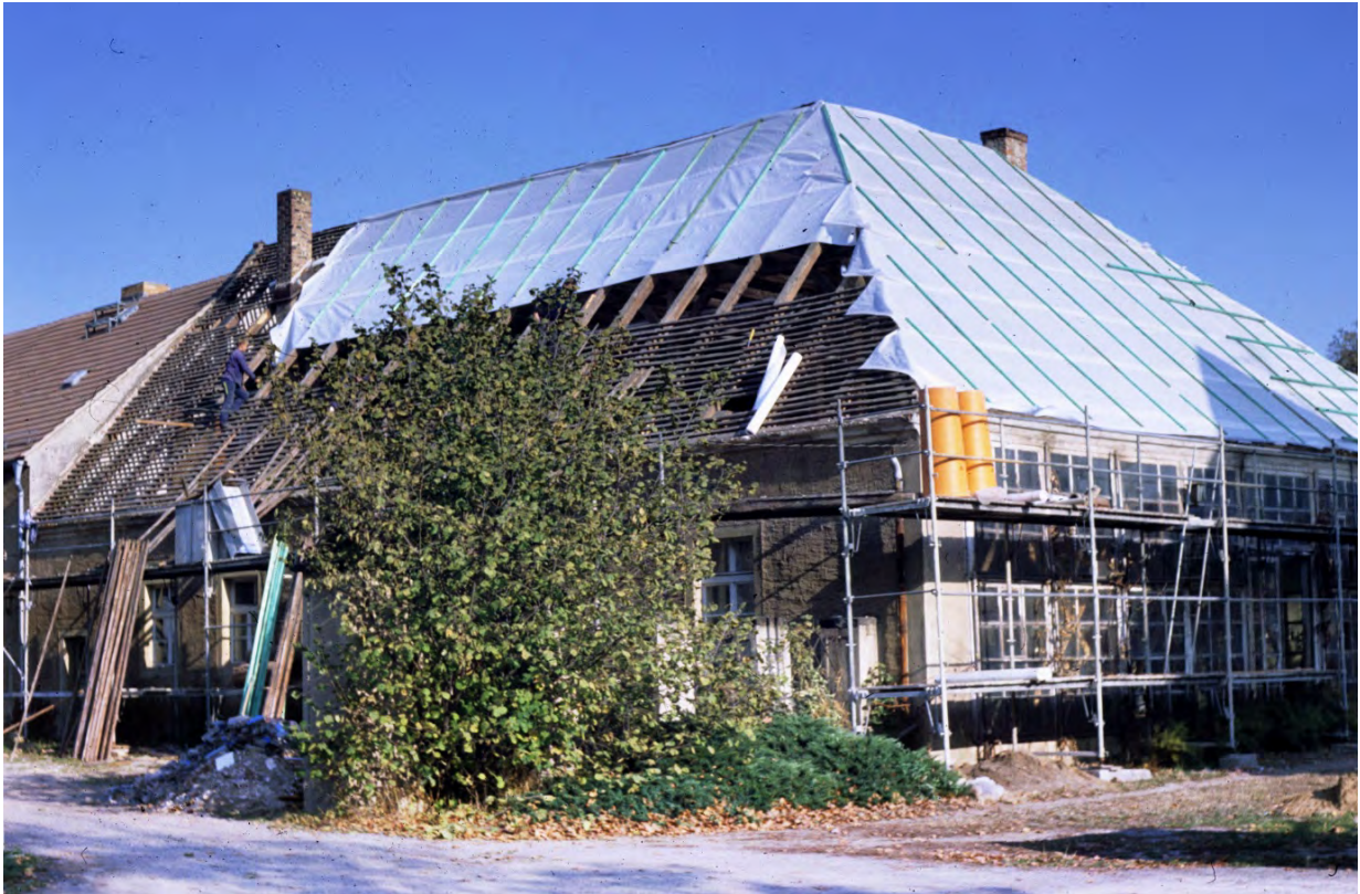
Umbau des Orangeriegebäudes
