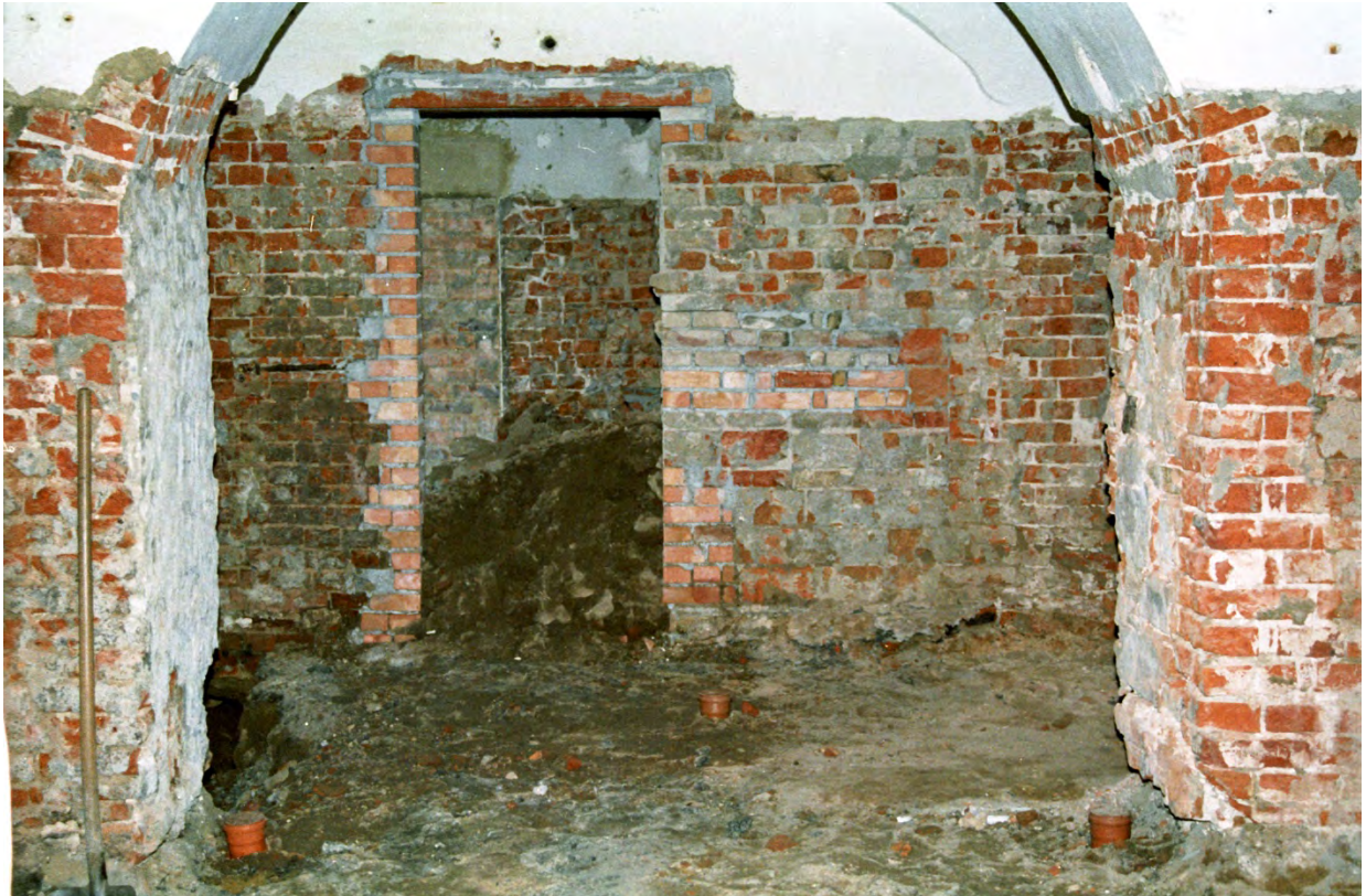
1995 Rekonstruktion Küche und Einbau Lehrküche
