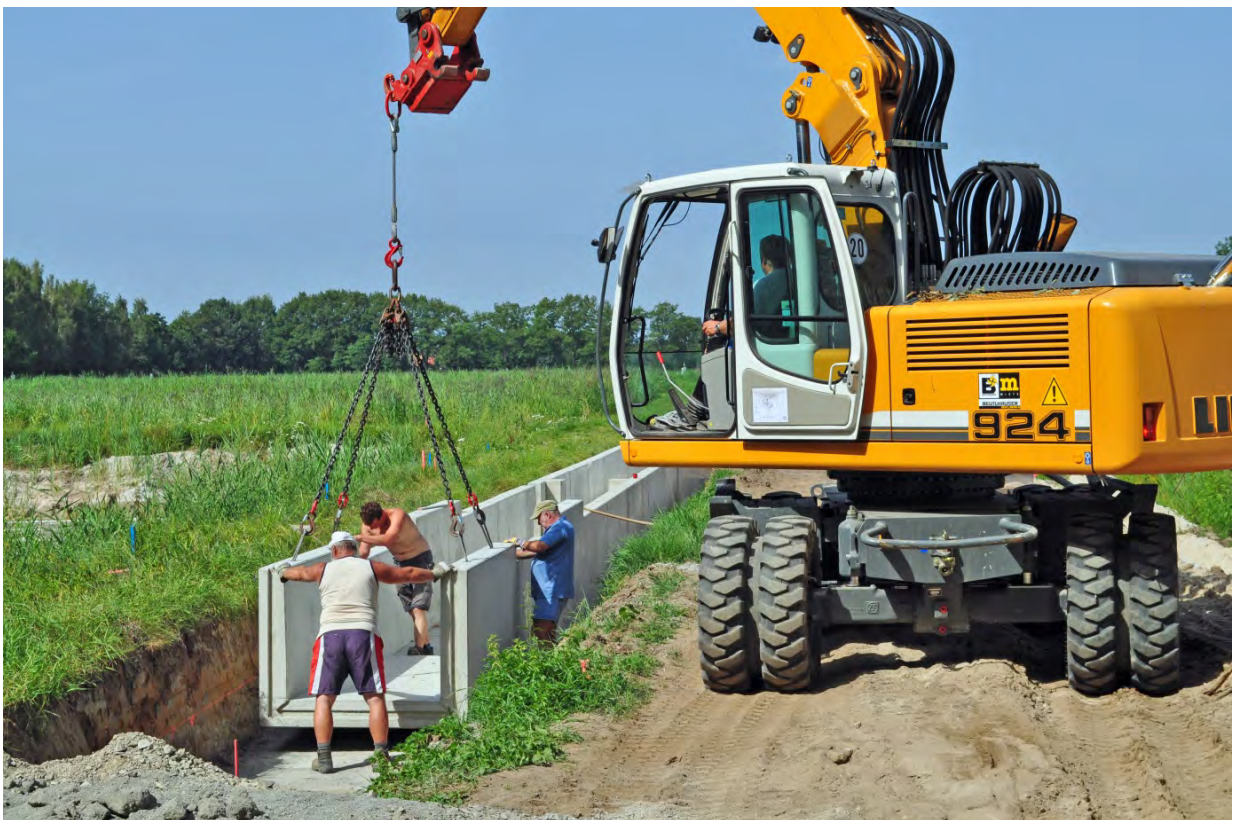
Verlegung Zuleitungsgraben ÜHA
