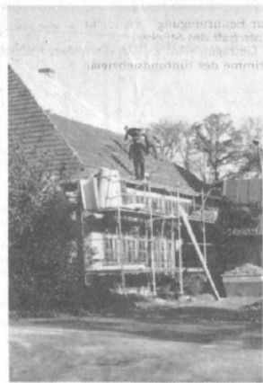
Zur Zeit werden Dach und Orangerie des Institutsgebäudes in Ordnung gebracht.
