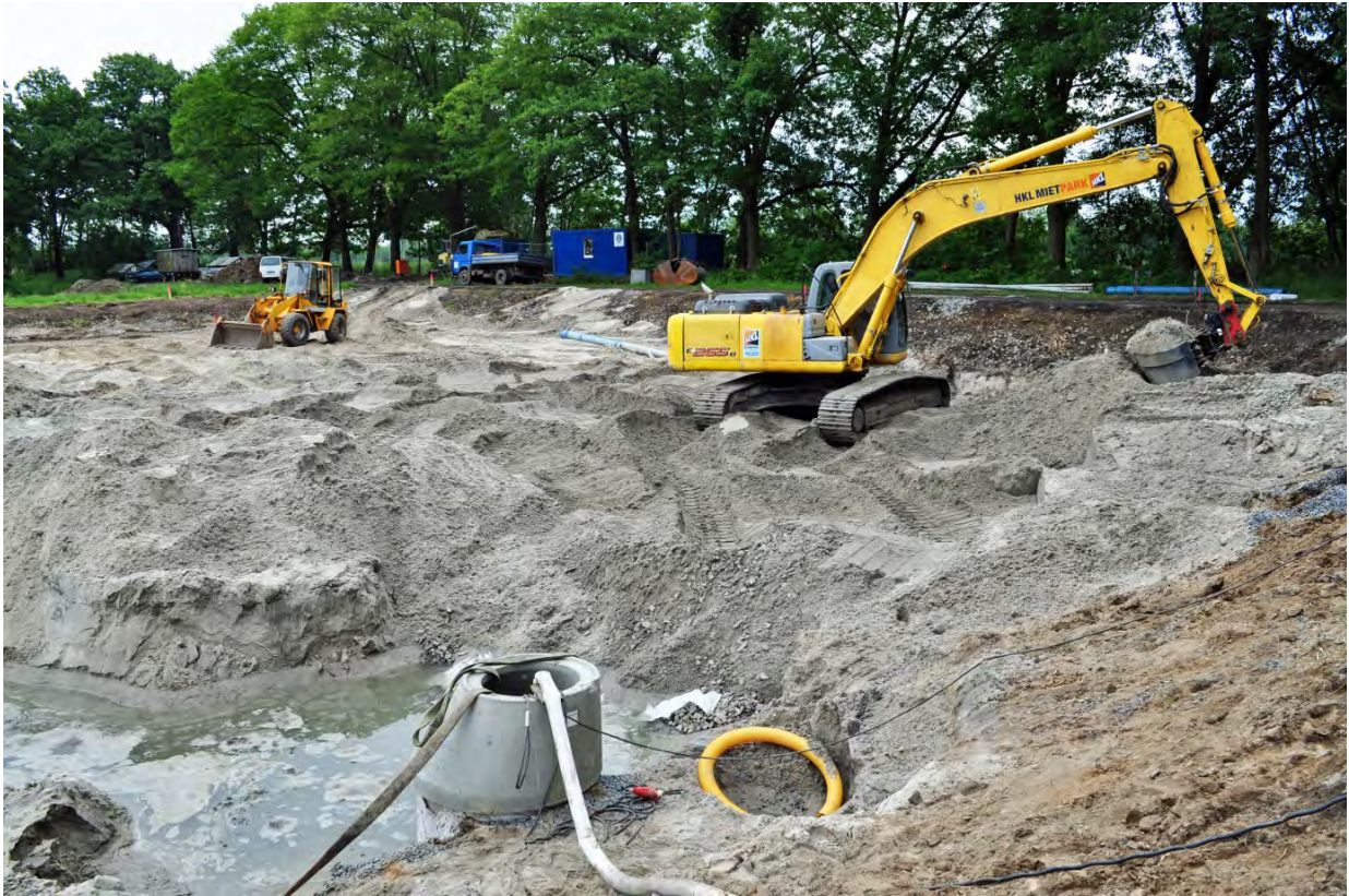
Bau der Überwinterungs- und Hälteranlage (ÜHA) 2012
