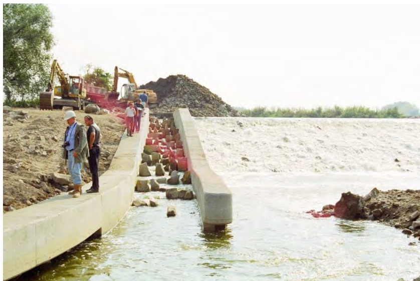
Abbildung 20: Baubegleitung bei der Errichtung der Fischaufstiegsanlage am Wehr Kollau 1999 (Vereinigte Mulde)
