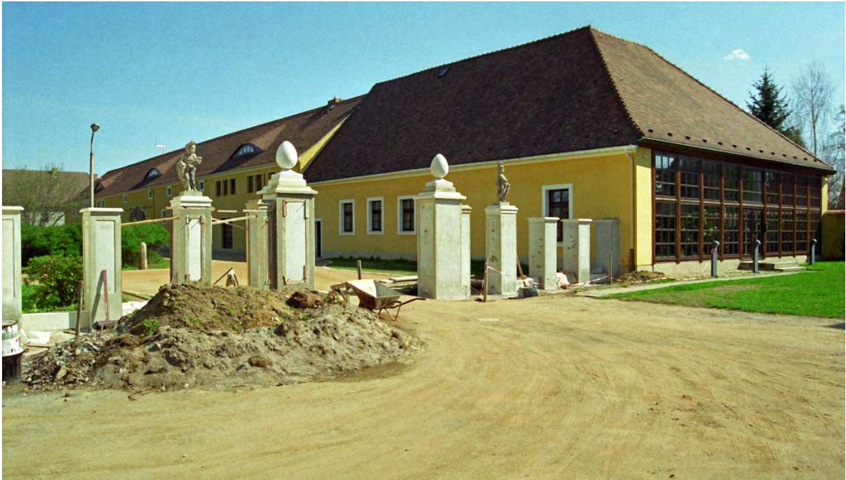
Neubau Toranlage zum Schlosspark 1999
