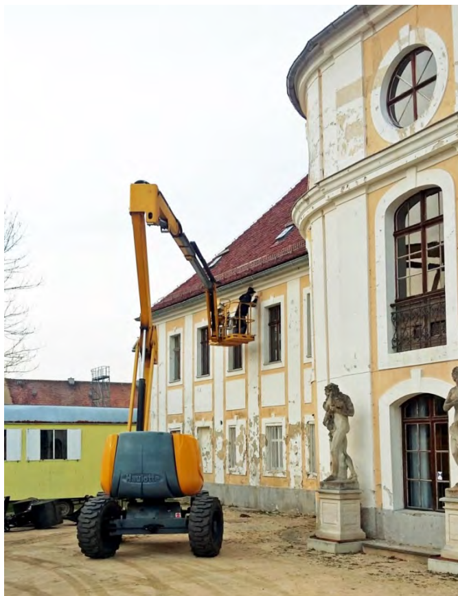
Abbildung 22: Farbuntersuchungen am Schloss in Vorbereitung der geplanten großen Baumaßnahme
