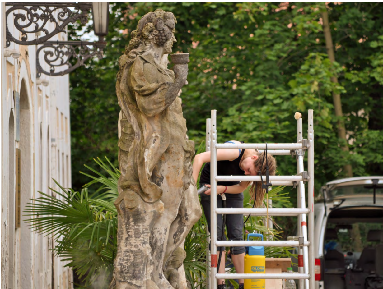
Sanierung der Sandsteinfiguren 2011
