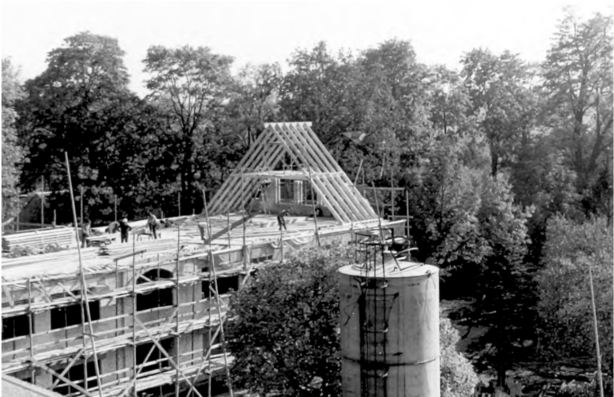
Neubau Schulgebäude – der Dachstuhl wird errichtet
