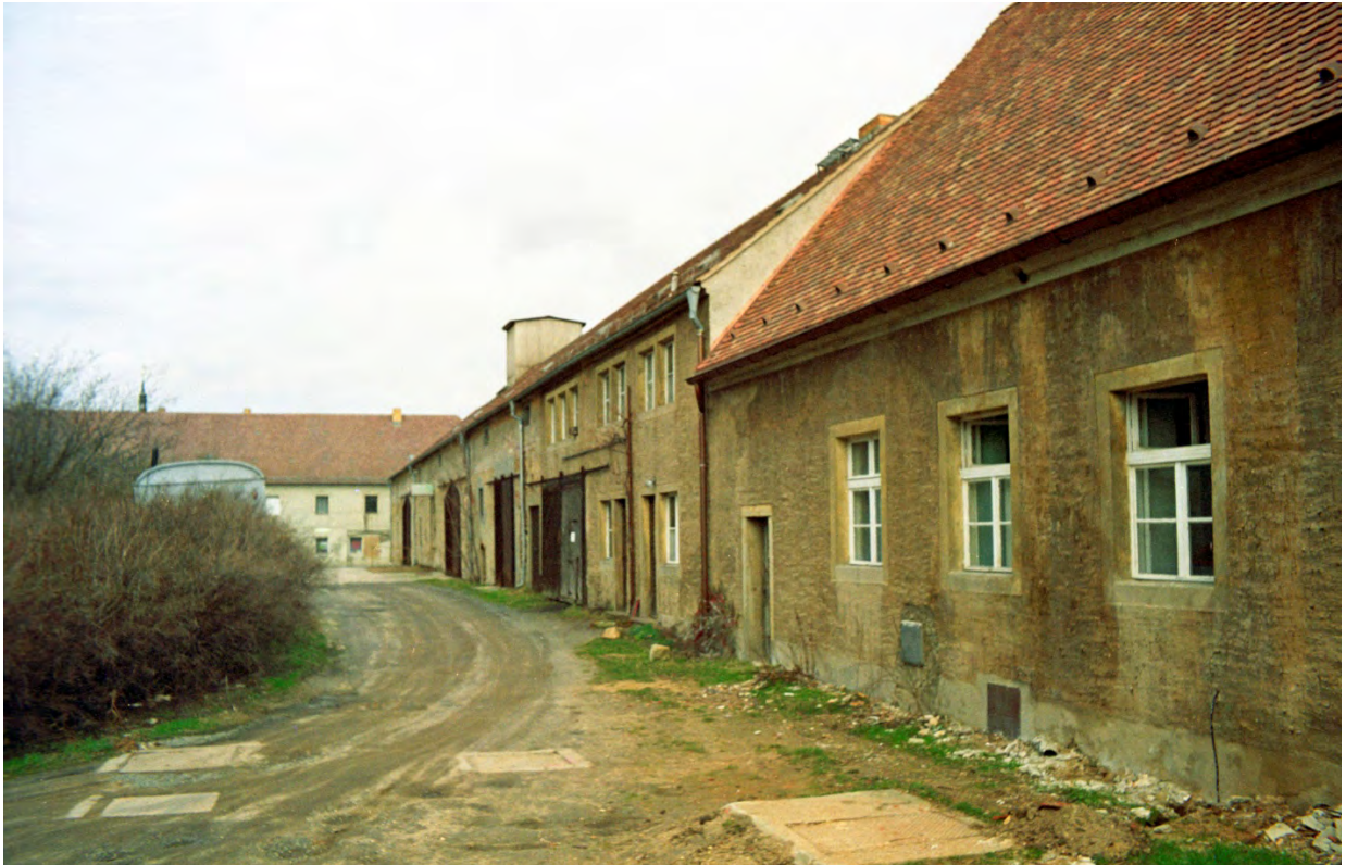
Zustand der Dienstgebäude 1991
