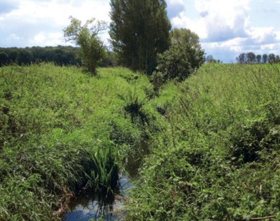
Abb. 4: Zschampert im FFH-Gebiet Bienitz und Moormergelgebiet; 20.08.2017, Foto: N. Jäger
