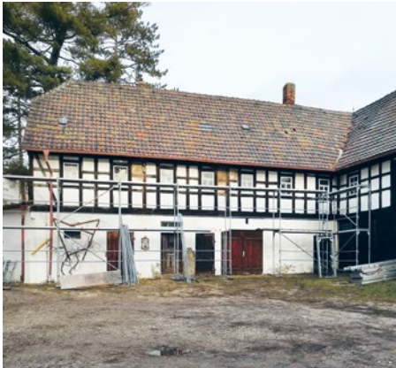
Abb. 18: Bauarbeiten am Standort Gräfenmühle in Neukirchen/Pleiße 2019 Foto: R. Albani
