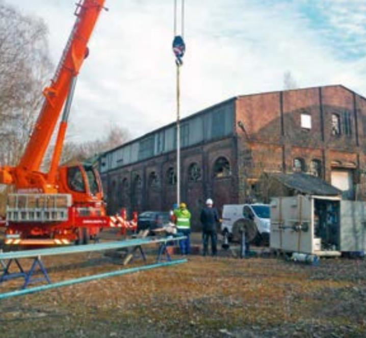
Abb. 9: Einbau der Probenahmetechnik an der GW-Messstelle Gersdorf-Kaisergrube
