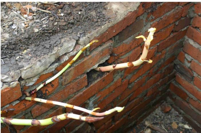
**Abbildung 5: Beschädigung einer Mauer durch junge Knöterichpflanzen,** Foto: Kerstin Tschiedel
