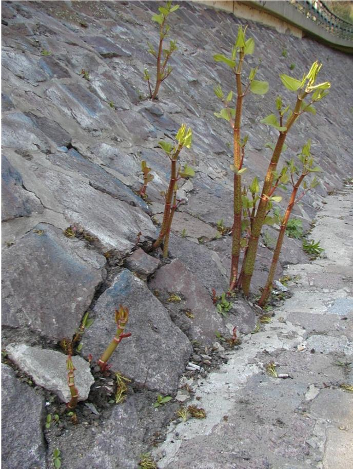
**Abbildung 6: Nach dem Hochwasser 2002 neu errichtete Uferbefestigung an der Weißeritz, Mai 2006, Foto: LfULG**
