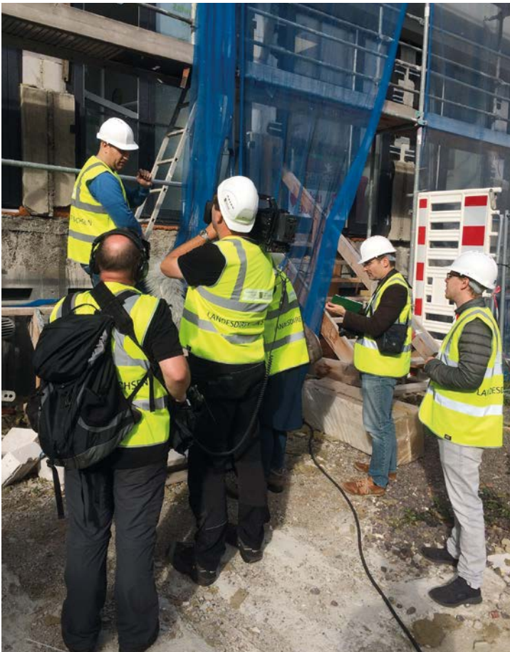
Bereits beim Aufstieg auf das Gerüst gingen die Probleme los. LDS-Mitarbeiter Thomas Tetzner (auf dem Gerüst) erklärt der anwesenden und hochinteressierten Presse die Vorschriften, wie ein sicherer Zugang zum Gerüst gewährleistet werden muss.
