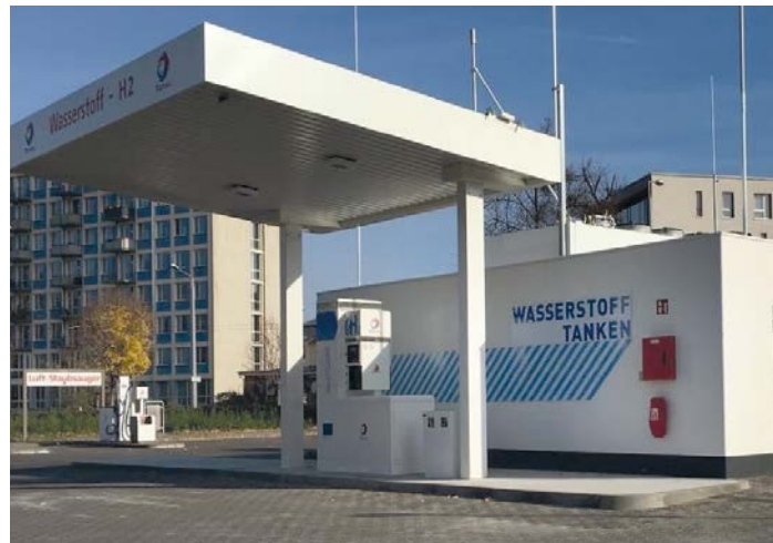
2.4.2 / Abbildung 1: Wasserstoffgasfüllanlage Dresden
