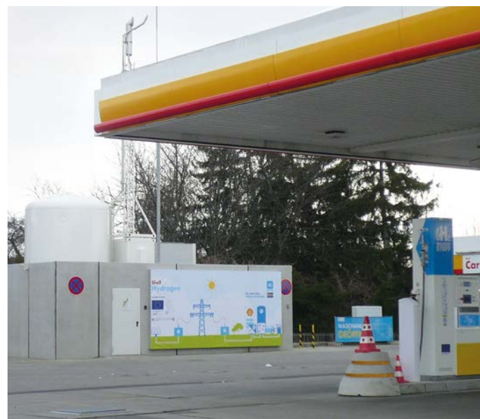
2.4.2 / Abbildung 3: Wasserstoffgasfüllanlage Meerane (im Bau)
