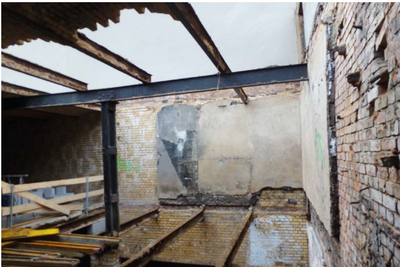
2.5.3 / Abbildung 1: Decken und Fußböden entfernt, ohne dass im Bereich der Wände der Rückbau des Teerkorks stattgefunden hat.
