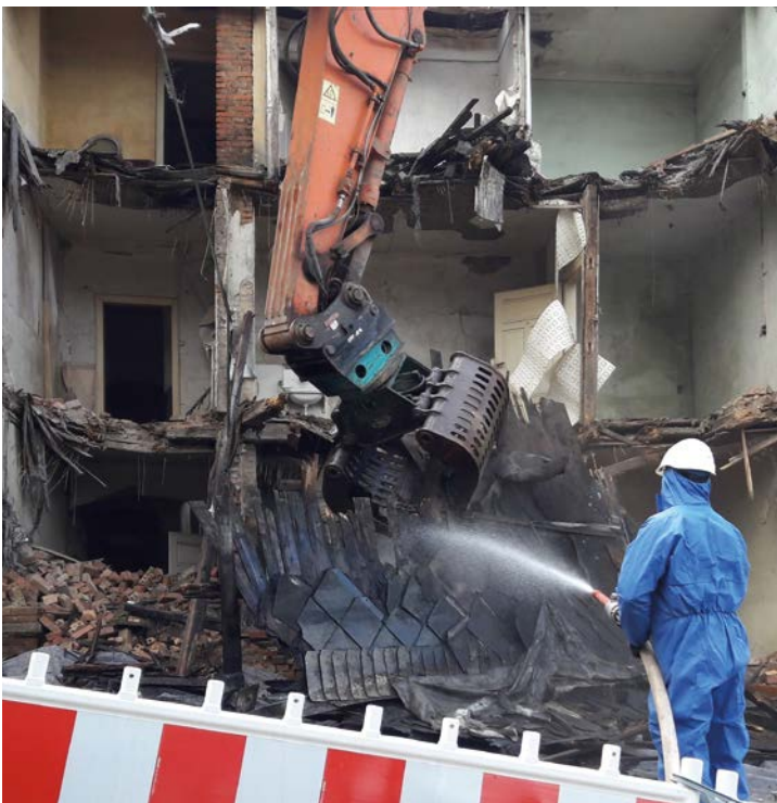
2.5.4 / Abbildung 1: Ablegen eines Dachteilstücks
