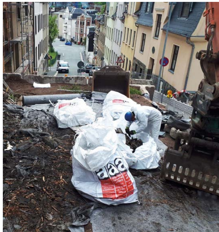
2.5.4 / Abbildung 2: Sortieren und Verpacken asbesthaltiger Baustoffe
