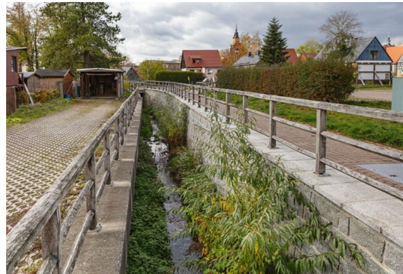
Heute sind die natürlichen Auenbereiche durch Begradigung und Bebauung verloren gegangen. (Foto: Burkhard Lehmann, LfULG)
