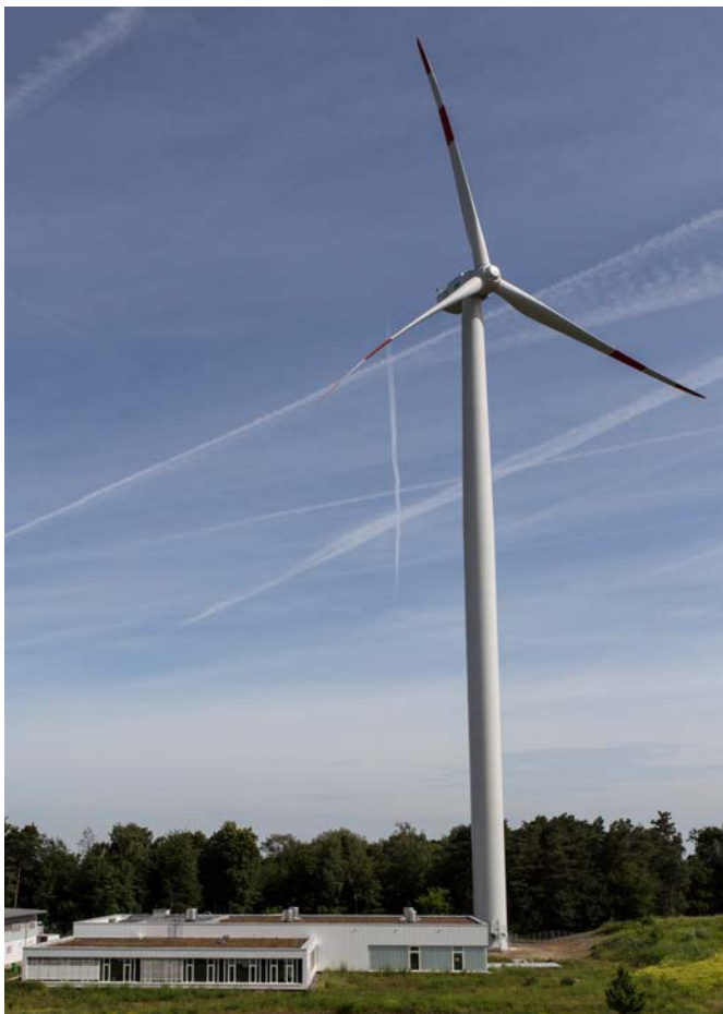
Abb. 5-2: Messobjekt: WKA mit einer Nabenhöhe von 101 m, einem Rotordurchmesser von 82 m und einer Leistung von 2 MW (Foto: Peter Fischer).
