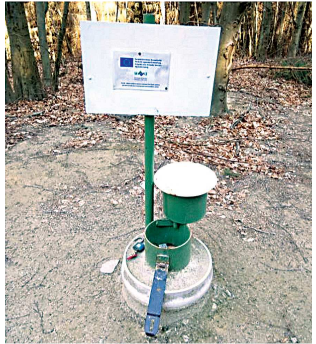
Abb. 3-5: Blick auf offenes Standrohr der Grundwassermessstelle RE002 bei Maxičky.
