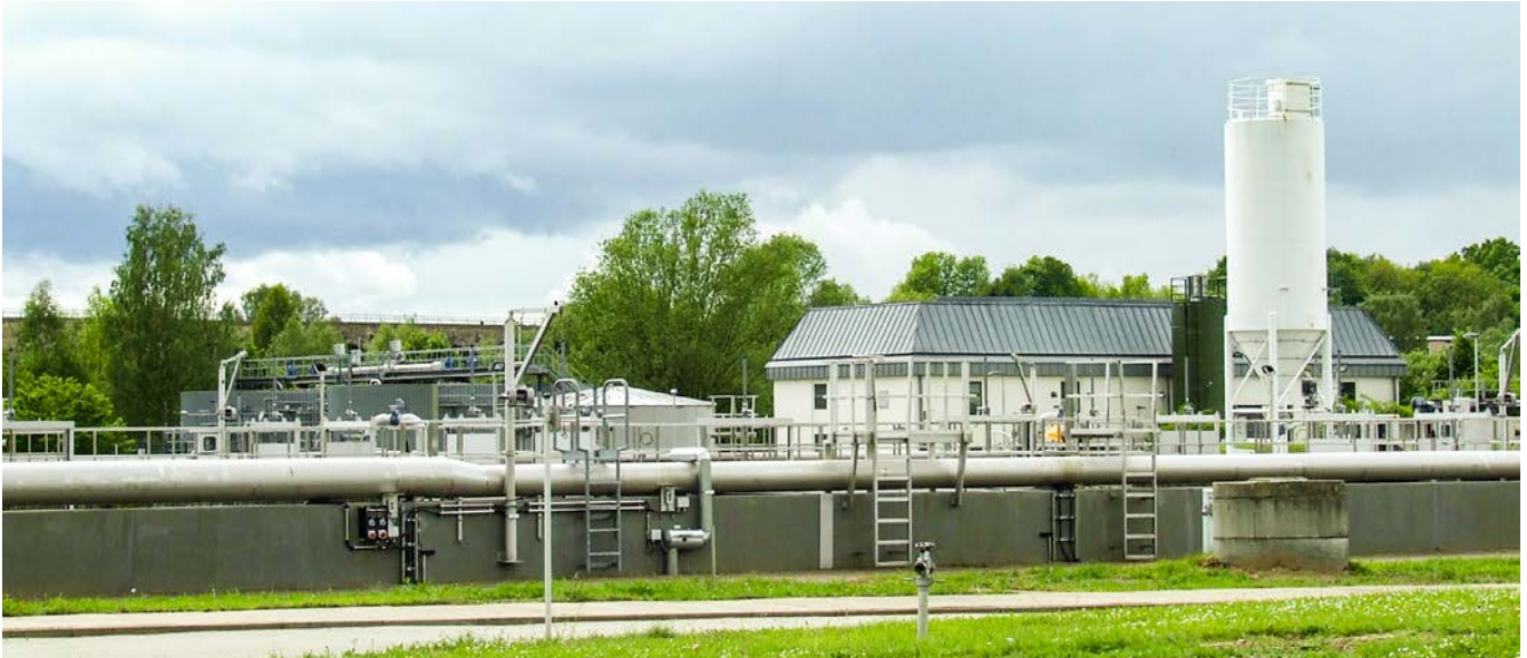
Kläranlage Zittau (Kapazität: 85.000 EW), Aufgabenträger: AZV Untere Mandau, Betriebsführer: Süd-Oberlausitzer Wasserversorgungs- und Abwasserentsorgungs- GmbH (SOWAG)
