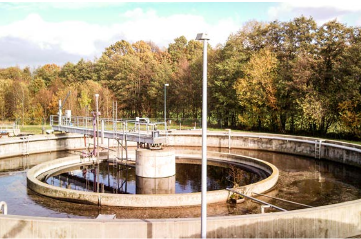
Kläranlage Höflein (Kapazität: 5.000 EW) Aufgabenträger: AZV Am Klosterwasser
