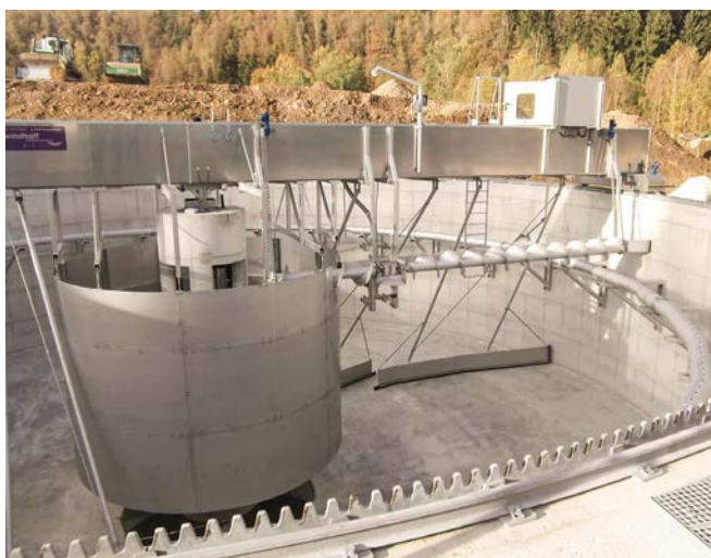
Kläranlage Hohentanne im Bau (Kapazität: 30.000 EW) Aufgabenträger: AZV „Muldental“
