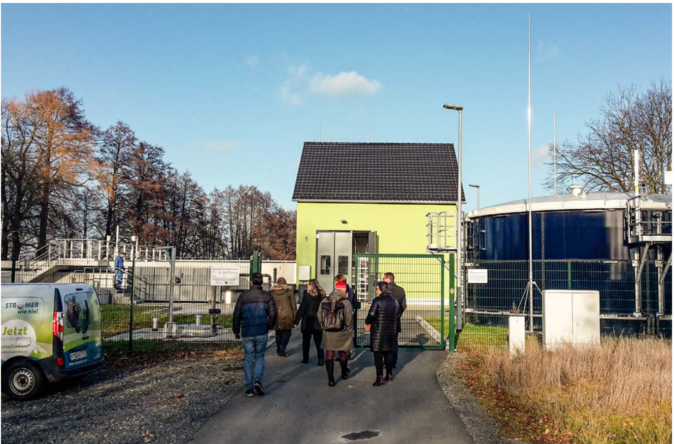
Kläranlage Schwepnitz (Kapazität: 2.200 EW) mit nachgerüsteter Stickstoff- und Phosphorreinigungsstufe, Aufgabenträger: Gemeinde Schwepnitz
