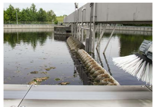
Kläranlage Freiberg (Kapazität: 10.000 EW) Aufgabenträger: Freiburger Abwasserbeseitigung
