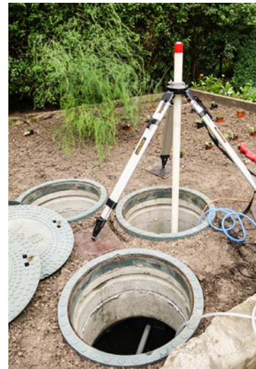
Dichtheitsprüfung einer privaten Kleinkläranlage durch Mitarbeiter der Stadtentwässerung Dresden
