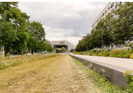
Innerstädtische Grünflächen in Dresden: direkte Versickerung von Niederschlagswasser vor Ort
