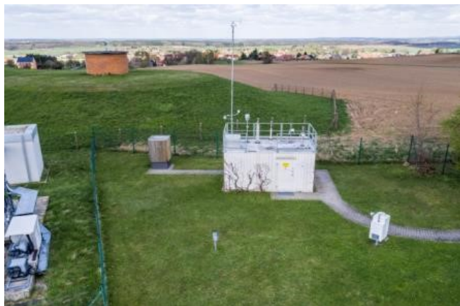
Foto: Burkhard Lehmann, LfJULG, 17.05.2017
