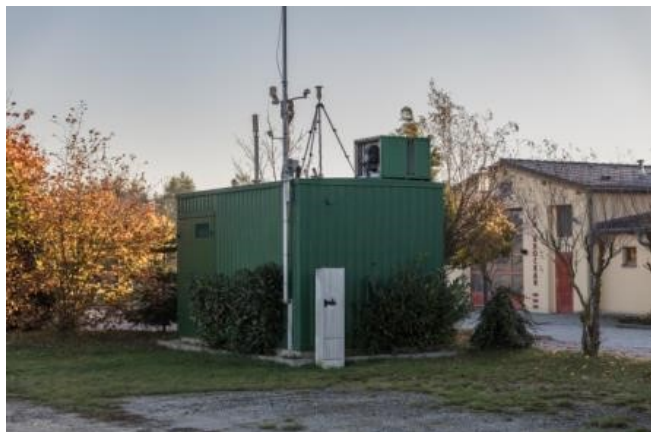
Foto: Burkhard Lehmann, LfJULG, 19.10.2017
