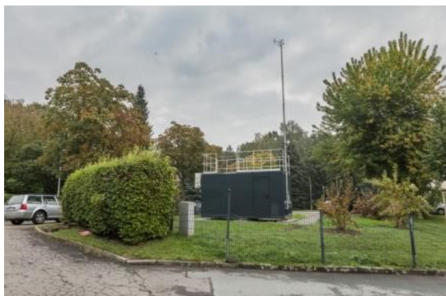
Foto: Burkhard Lehmann, LfJULG, 21.09.2017
