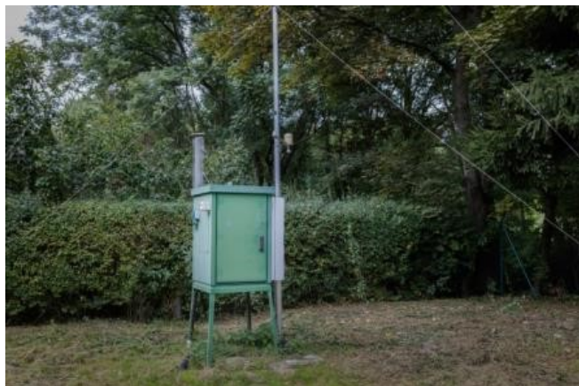
Foto: Burkhard Lehmann, LfJULG, 20.09.2017
