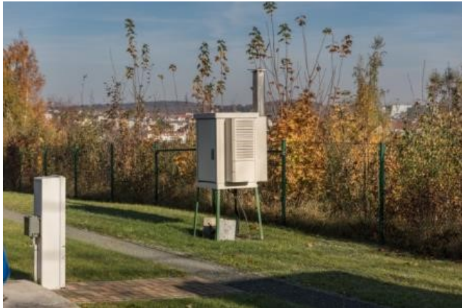
Foto: Burkhard Lehmann, LfJULG, 19.10.2017
