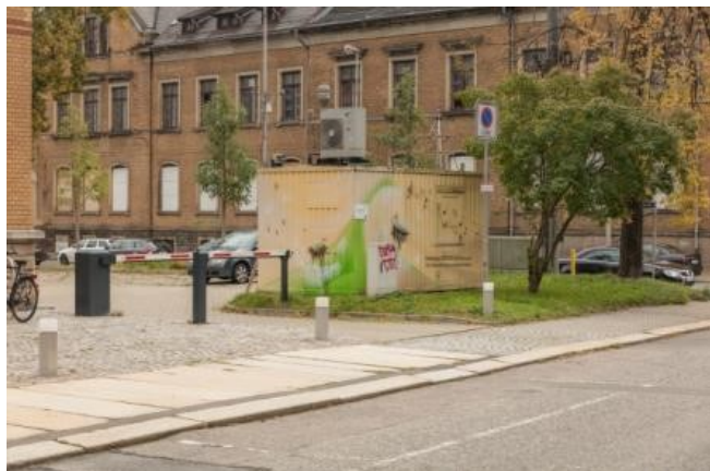
Foto: Burkhard Lehmann, LfJULG, 21.09.2017
