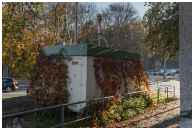
Foto: Burkhard Lehmann, LfJULG, 19.10.2017
