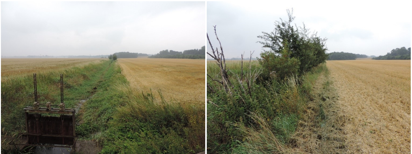
Abbildung 1: Ottendorfer Saubach – geradliniges Trapezprofil ohne Gehölze (links) bzw. vereinzelt Gehölzen (rechts) mit angrenzenden Ackerflächen bis an die Böschungsoberkante
