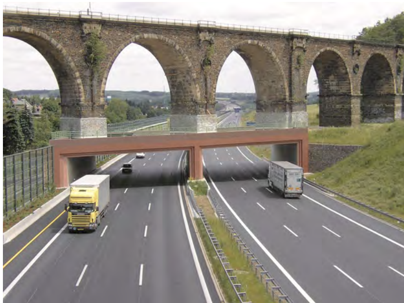
Bild 7 Erweiterung A 4 VDE, Bahrebachmühlenviadukt bei Chemnitz (© DEGES)
