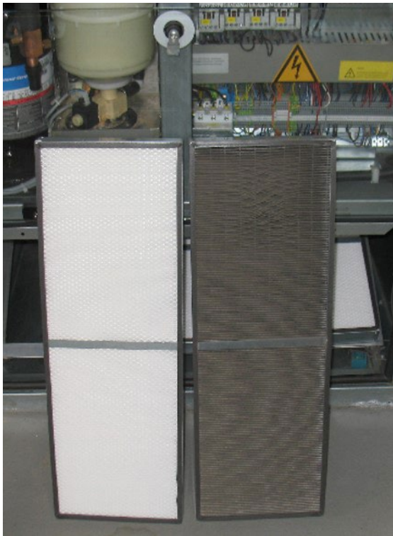
Abbildung 3: Vergleich Kompaktfilter neuwertig und am Ende der Standzeit
