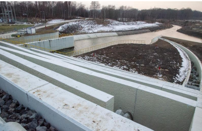
Fertiggestellte Fischpassage am Witka Staudamm (Polen), Foto: Jacek Staszuk
