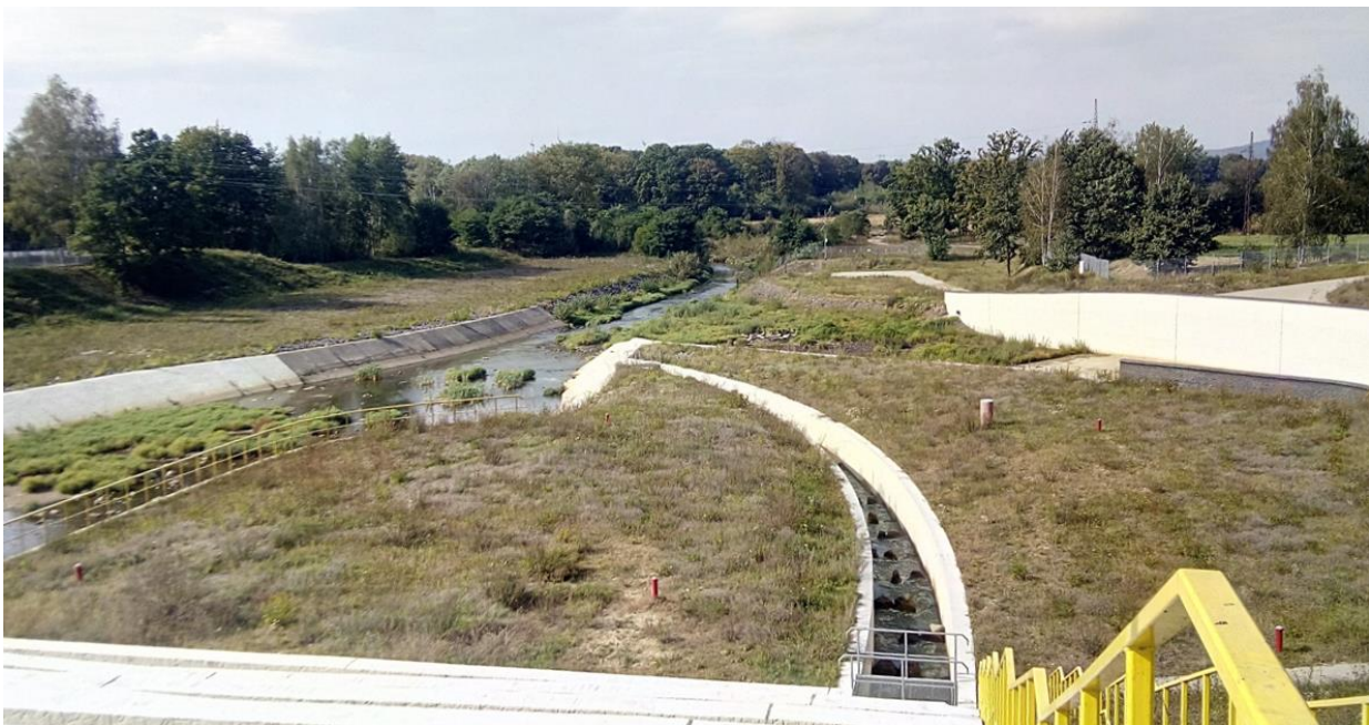
Abbildung 12: Teil der Fischaustiegsanlage des im Jahr 2017 neu erbauten Damms des Niedów-Stausees (auch Witka-Stausee genannt) am Fluss Witka (Wittig) in der Nähe der Ortschaft Niedów (Nieda) in Polen, Foto: IMGW-PIB
