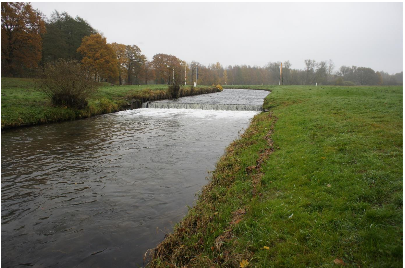
Abbildung 2: Abschnitt der Lausitzer Neiße mit stark bis sehr stark veränderter Struktur, Flusskilometer 198. Veränderungen betreffen das Flussbett (Sohlschwelle), die Ufer (befestigt) und das angrenzende Land
