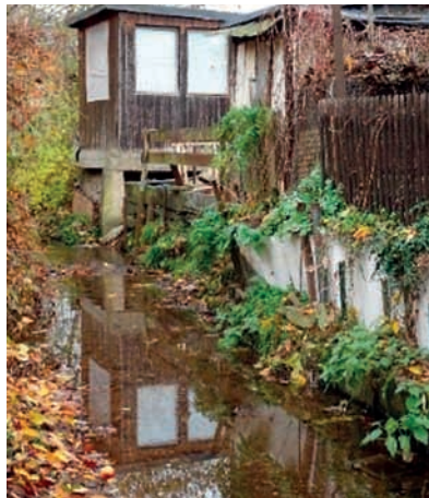
Uferverbau in Massivbauweise und wilder Verbau | Visualisierung von schadensrelevanten Randbedingungen und Verletzbarkeit in den Fallstudiengebieten
