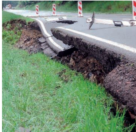
Typische Schadensbilder und Darstellung der Verletzbarkeit an Straßenverkehrsinfrastrukturen im potentiellen Überflutungsbereich der Smědá bei Frýdlant
