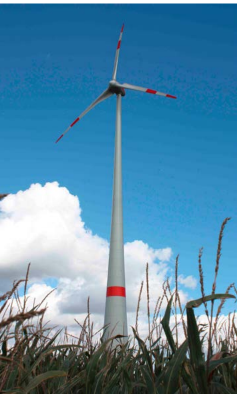
Windenergieanlage in Zschadraß-Bockwitz.
