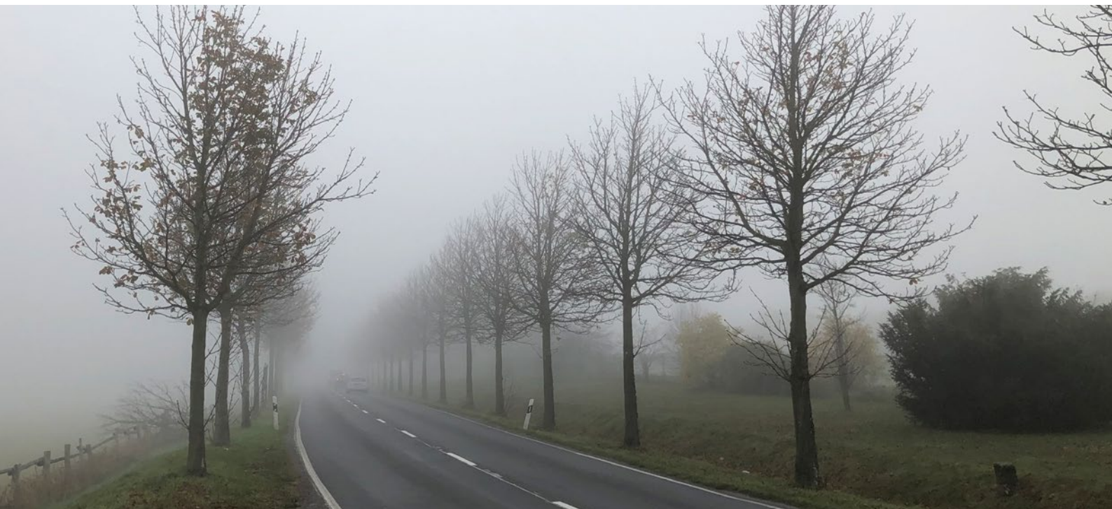
Abb. 4: Allee im Nebel – Straße mit beidseitiger Pflanzung von Rosskastanien ohne passive Schutzeinrichtung
