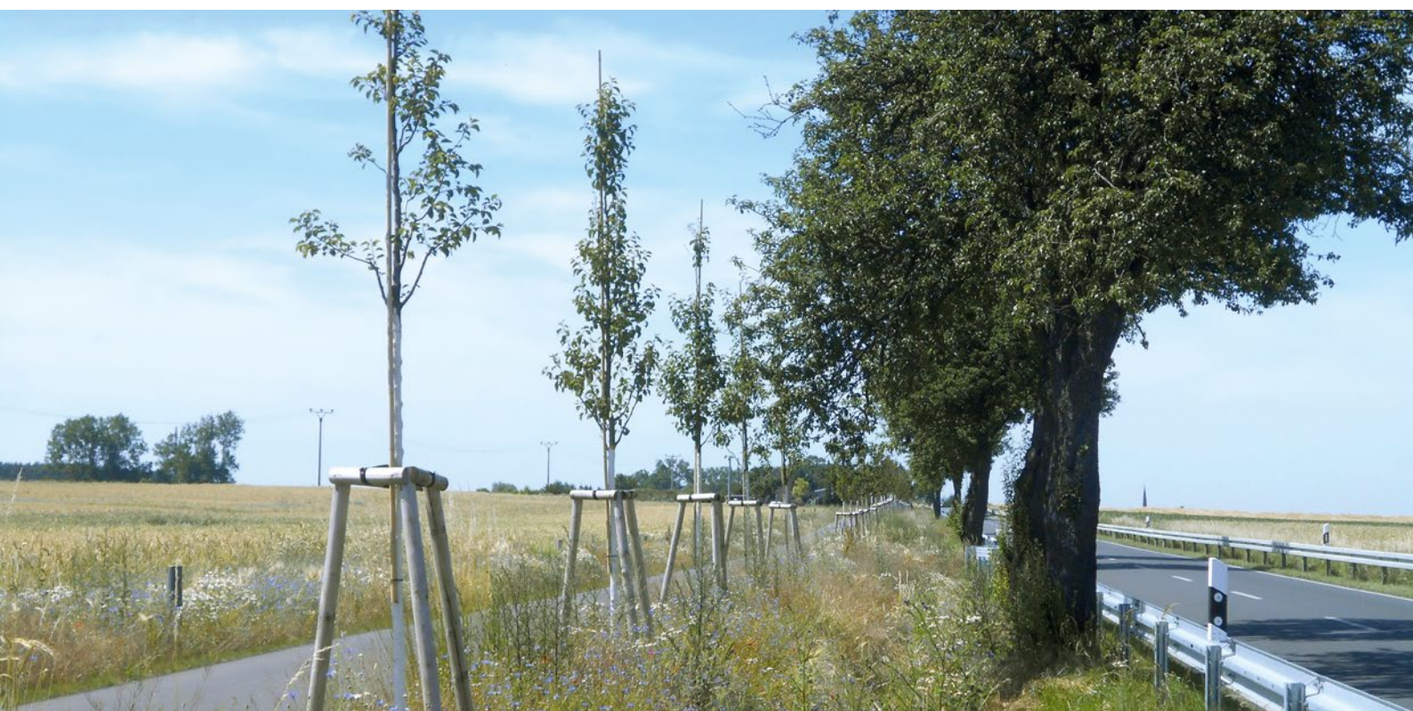
Abb. 8: Wiederherstellung einer Baumreihe (Alterungsphase) durch Neupflanzung in zweiter Reihe mit erhöhtem Fahrbahnabstand, B 104 bei Pasewalk
