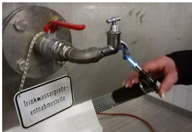
Abbildung 2: Probenahmestelle für Trinkwasserproben
