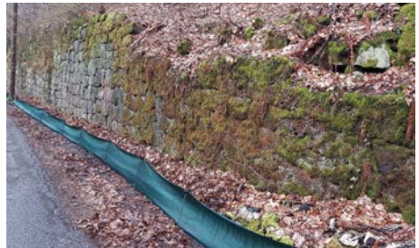
Abb. 13: Trockenmauer entlang der Ortsverbindungsstraße zwischen Struppen und Obervogelgesang. Oberhalb der Mauer befindet sich die Hangseite, die von den Feuersalamandern als Lebensraum genutzt wird.
