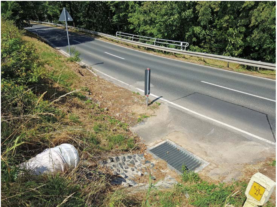
Abb. 20: Rohr zur Ableitung des Oberflächenwassers vom Maisfeld. Die Einleitung des Wassers erfolgt in den hangabwärts gelegenen Struppenbach.
