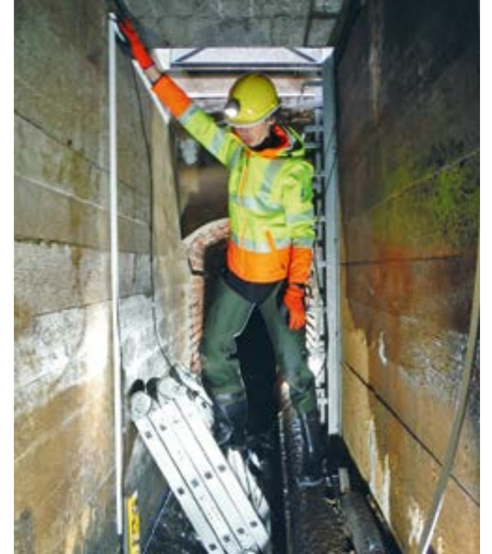
Abb. 6: Einbau Messtechnik im Reiche Empfängnis Stolln Frohnau
