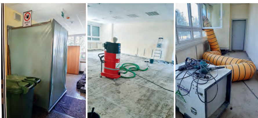
2.5.2 / Abb. 4 bis 6: Nachher: PAK-Sanierung durch eine Fachfirma
