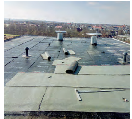
2.2.6 / Abb. 2: Ohne jeglichen Absturzschutz wird hier gearbeitet; aber mit einem tollen Blick über Chemnitz
