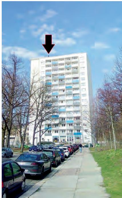
2.2.6 / Abb. 1: Kein Suizid-Versuch, Dachdecker bei der Arbeit
