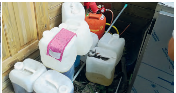
2.2.3 / Abb. 6: Frittieröl und Reinigungsmittel frei zugänglich im Außenbereich gelagert, direkt neben einer angeschlossenen Druckgasflasche
