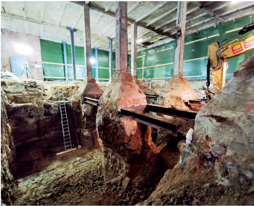
2.5.4 / Abb. 2: Austausch von kontaminierten Böden mit einer Grabentiefe bis zu 5,50 m – Unterfangung mit Düsenstrahl-/ HDI-Verfahren
