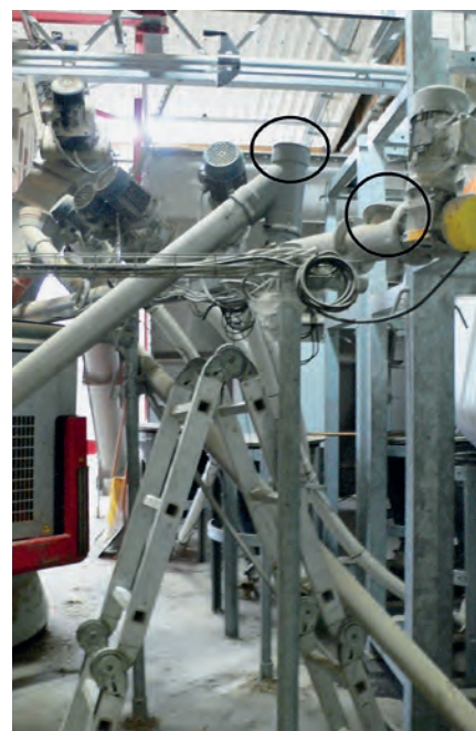
2.2.4 / Abb. 2: Unfallstelle Eingriff in offene Übergabestelle am Schneckenförderer
