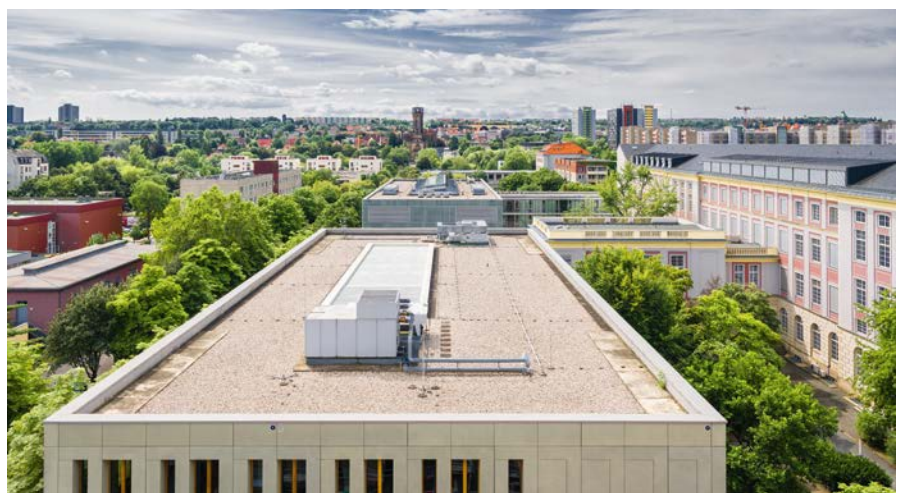
Blick über den Neubau
