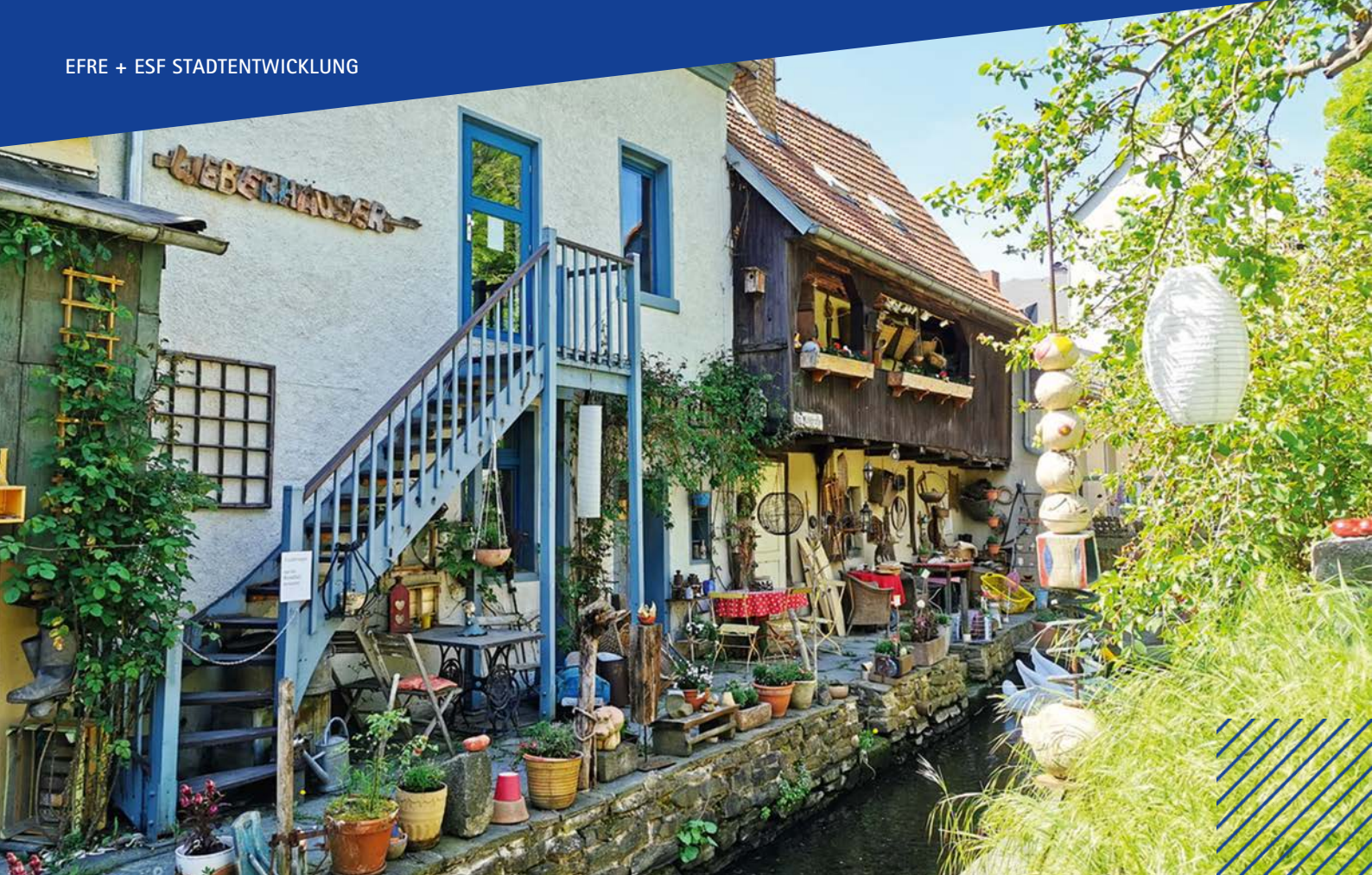
Die Weberhäuser nach der Sanierung
