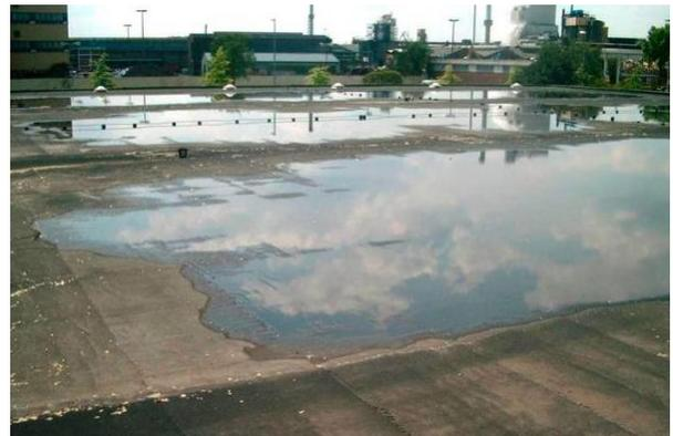
**Abbildung 4: Wassermassen verbleiben auf der Fläche; Sita Bauelemente GmbH, o. A.**
