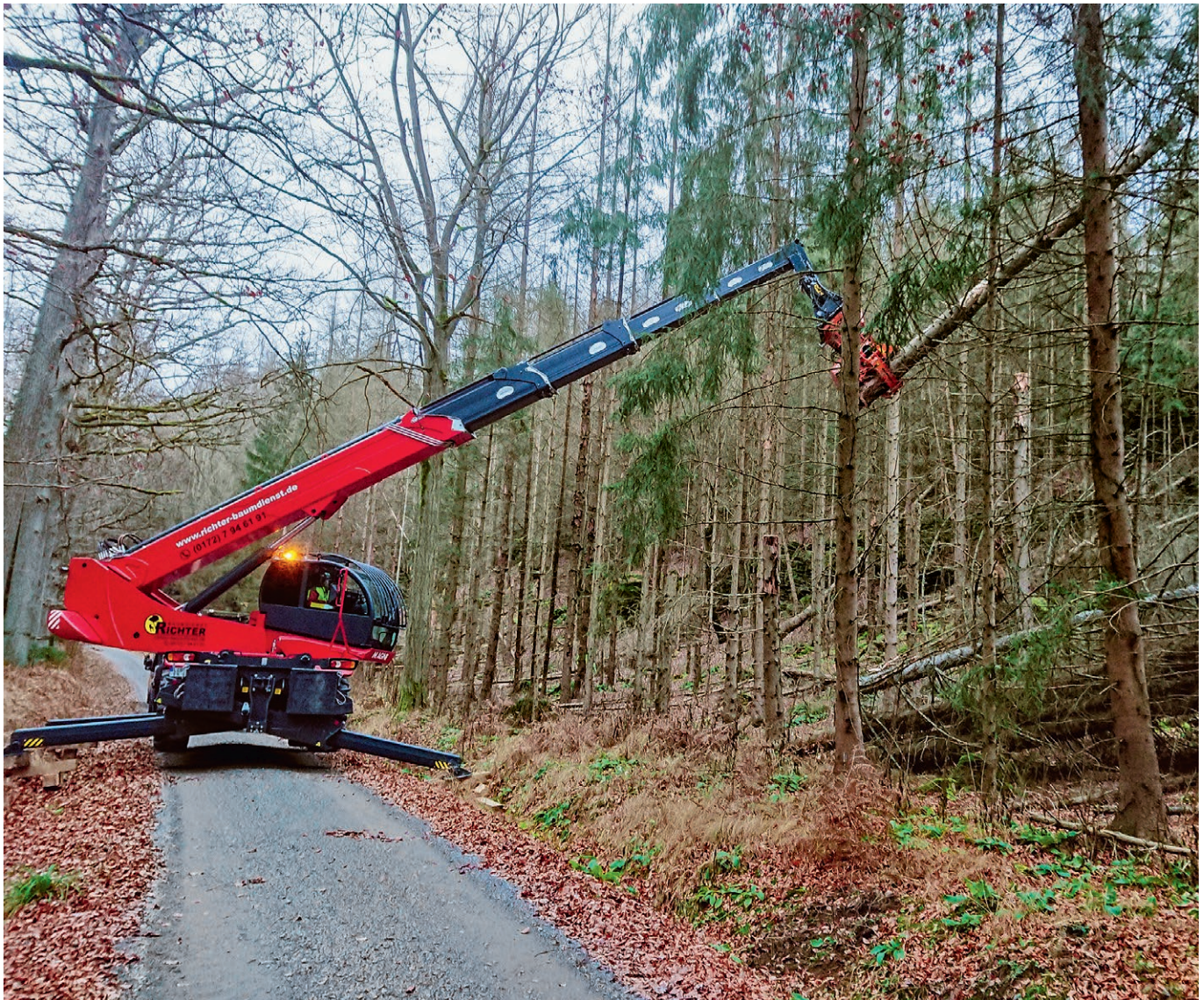
Abb. 1: Teleskopkran E-Flügel – dieses Verfahren ist das erste Mal überhaupt bei Sachsenforst hier im Nationalpark erprobt worden. Foto: Felix Heubaum
