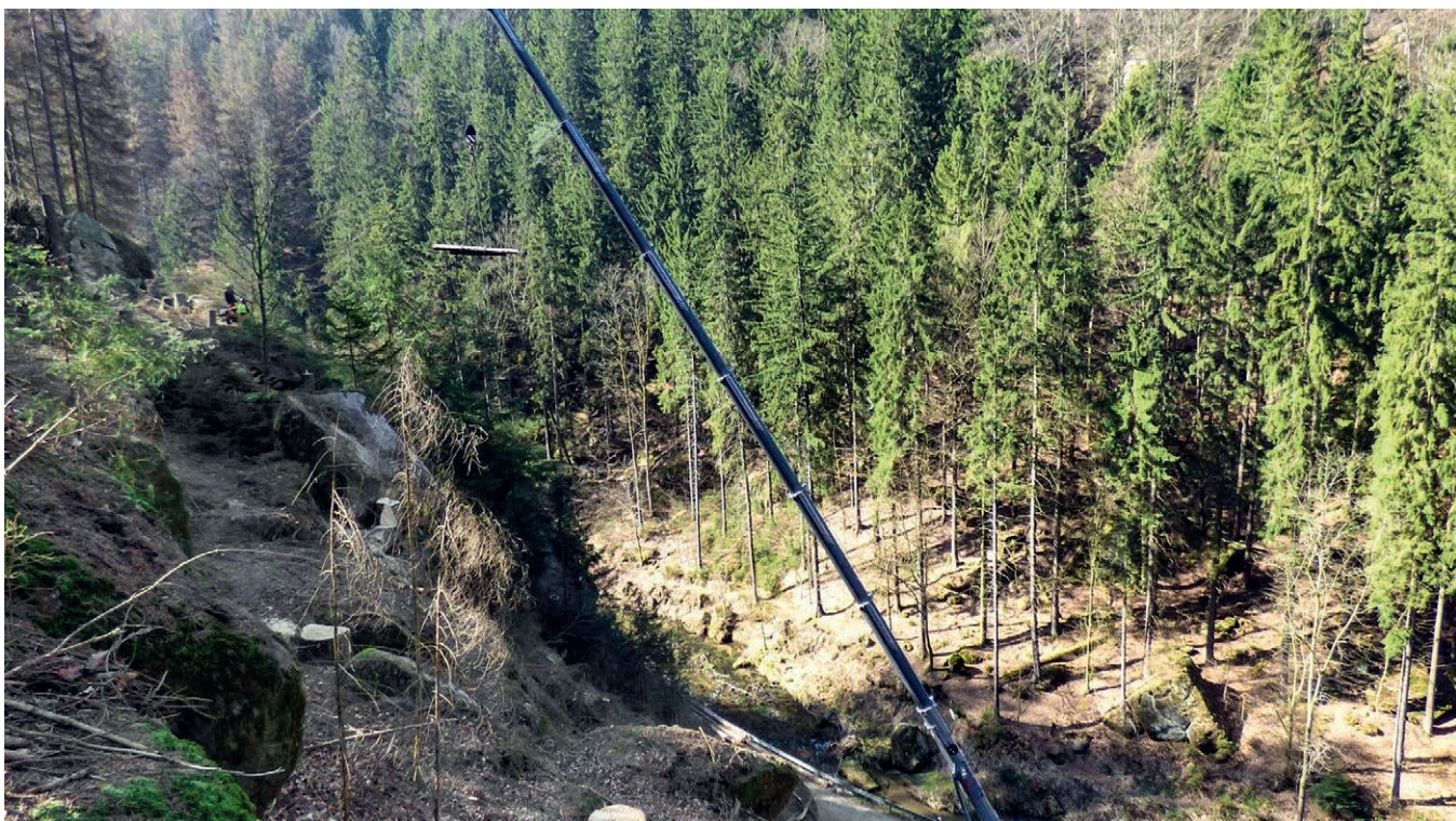
Abb. 5: Autokran Kirnitzschtal – mit seinem 70-m-Ausleger hat der Kran auch die schwierigsten Fichten auf Felsbändern erreicht. Foto: Helen Rößler
