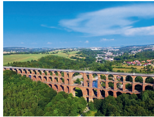
Göltzschtalbrücke - die größte Ziegelsteinbrücke der Welt; Bildquelle: Stadtverwaltung Reichenbach im Vogtland
