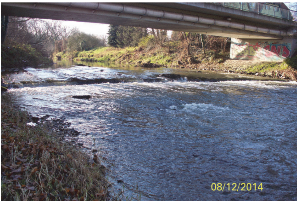
Abbildung 22: Wehrschwelle in der Weißen Elster vor dem Umbau
