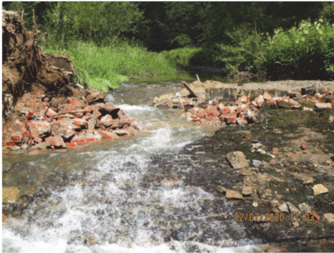
Abbildung 18: Rückbau des Wehres Ferienpark/Wilisch – Bauphase
