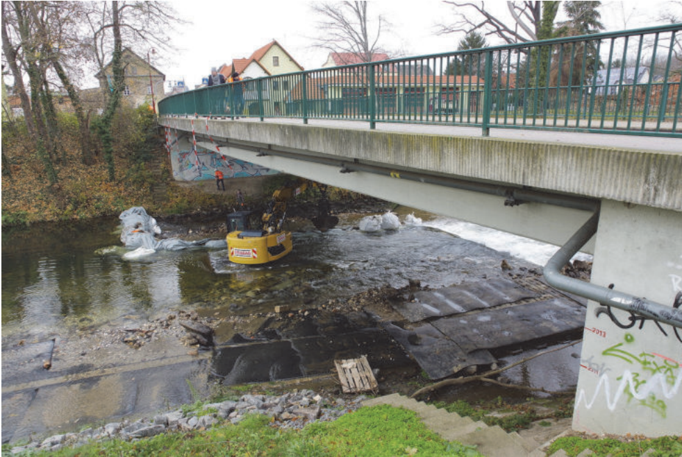
Abbildung 23: Während der Baumaßnahme
