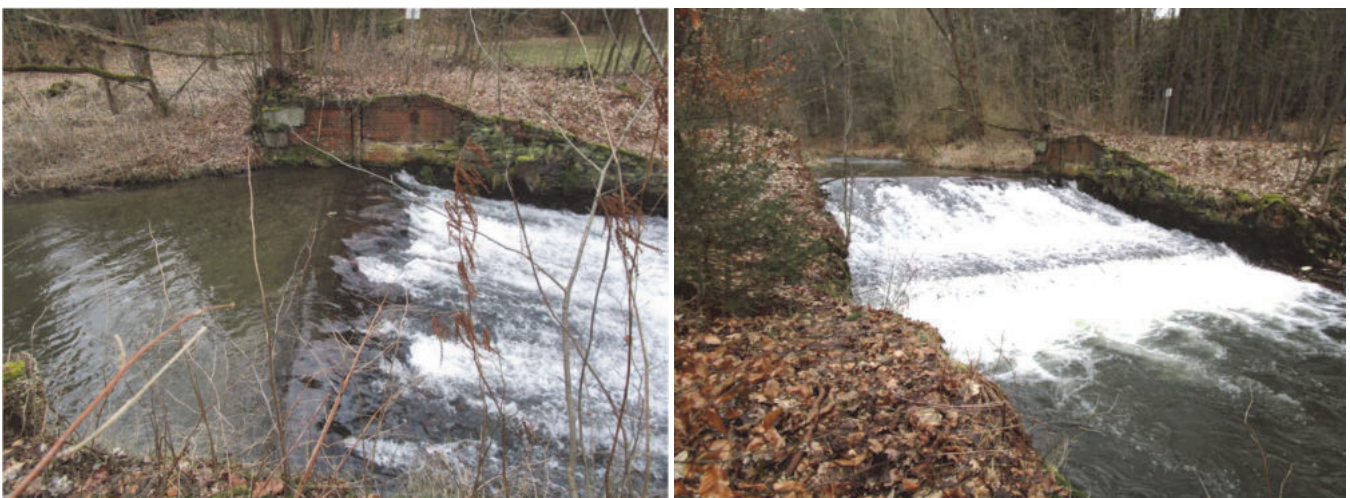
Abbildung 17: Wehr Ferienpark (Wilisch) vor dem Rückbau
