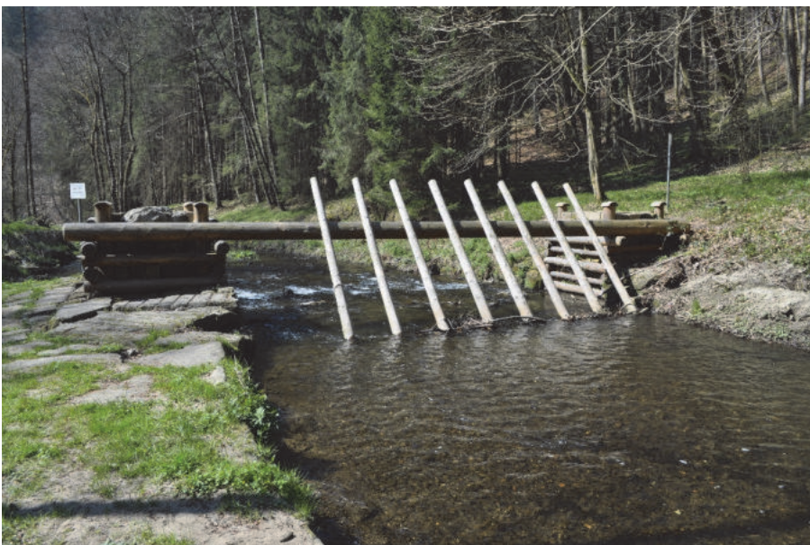
Abbildung 11: Totholzfang in der Polenz nahe der Frinztalmühle
