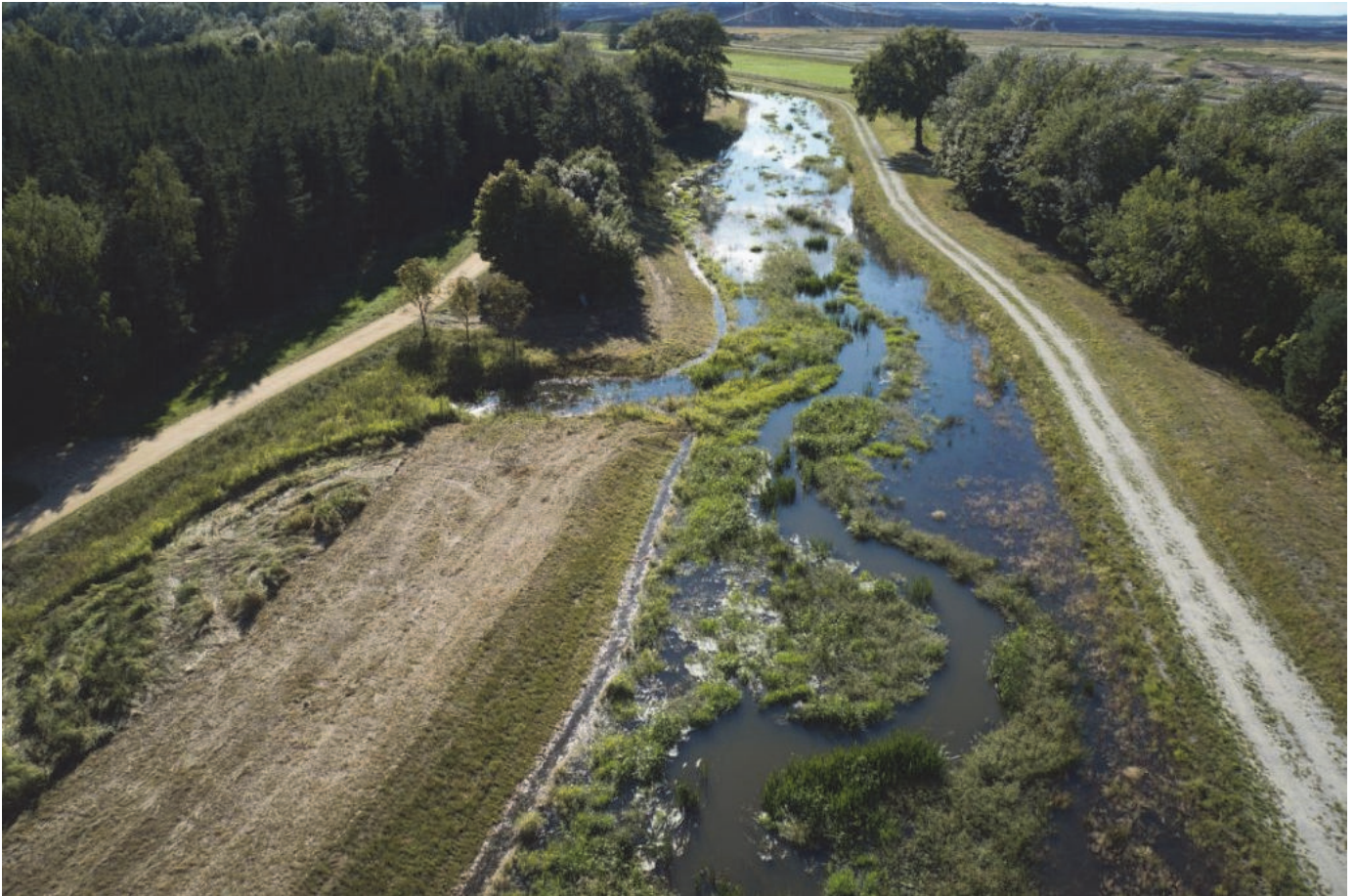
Abbildung 16: Umverlegung Weißer Schöps, Los 2: Neubaustrecke
