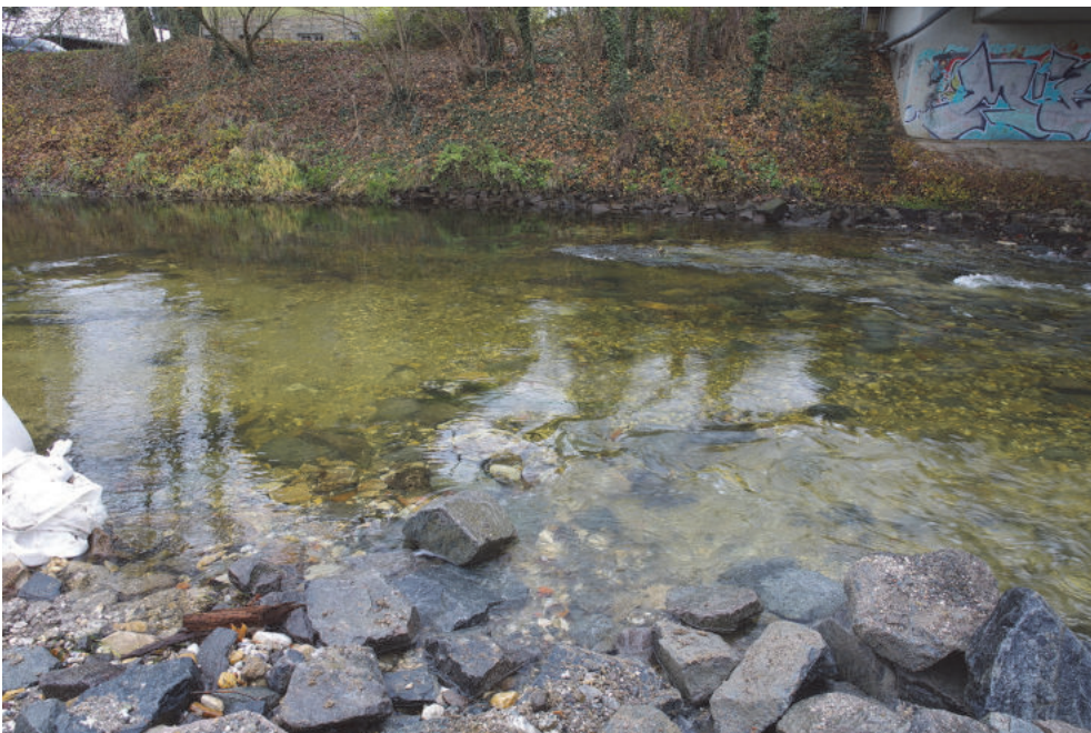
Abbildung 24: Zustand der Gewässersohle nach dem Rückbau der Wehrschwelle
