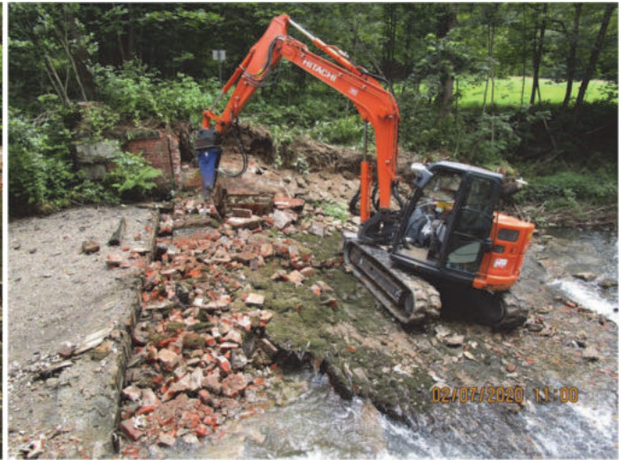
Abbildung 18: Rückbau des Wehres Ferienpark/Wilisch – Bauphase
