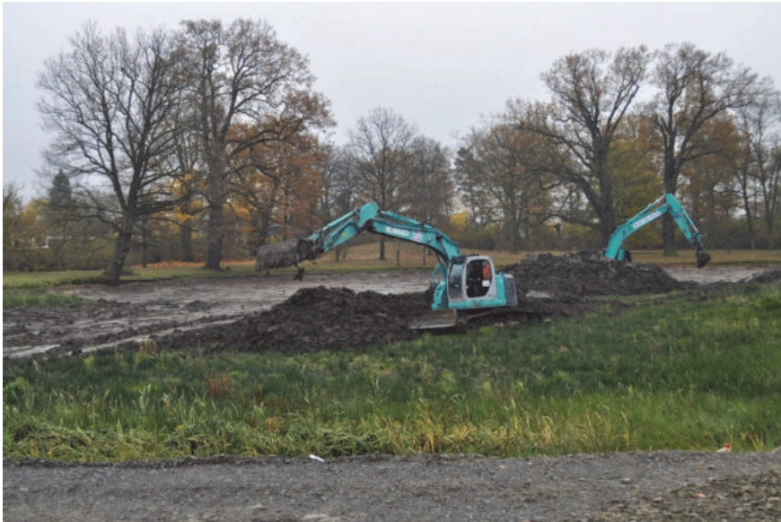
Abbildung 12: Entlandung eines Karpfenteiches
