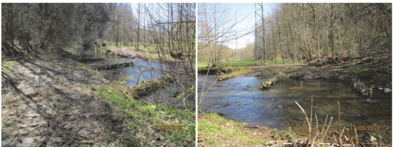
Abbildung 21: Abschnitt der Wilisch mit eingebauten Faschinen
