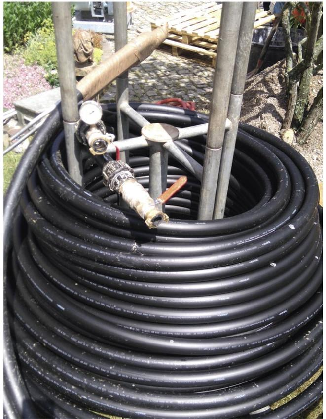
Abb. 4: Erdwärmesonde auf Haspel vor Einbau (LfULG/ M. Richter)
