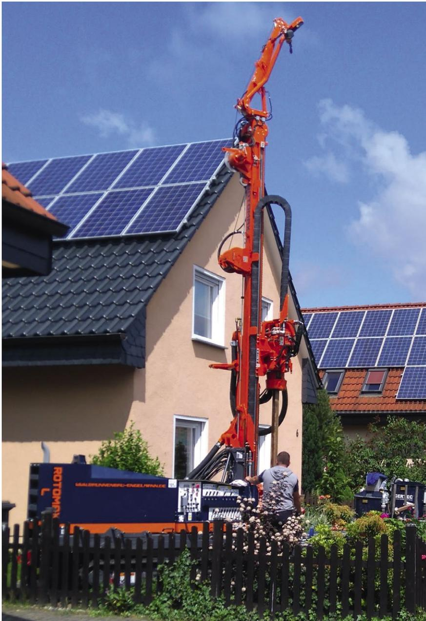
Abb. 1: Erdwärmesondenbohrung (LfULG/ M. Richter)
