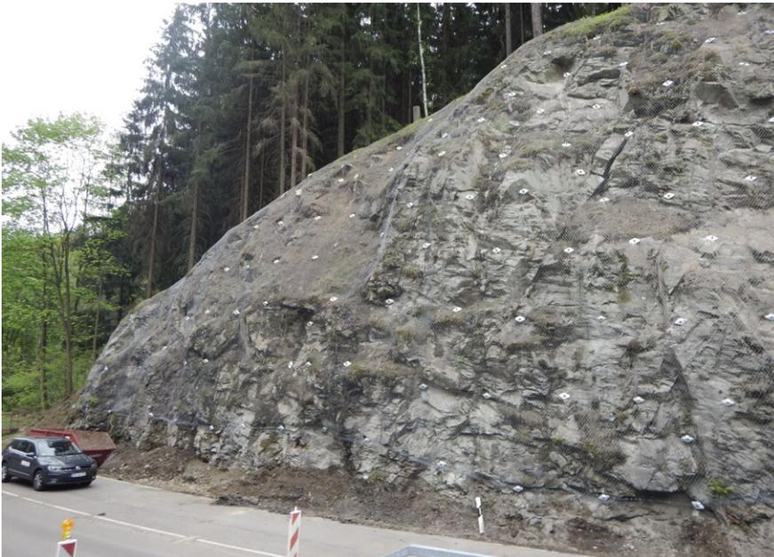
Abb. 5: Netzsicherung einer steinschlaggefährdeten Felsböschung. (LfULG/ Kulikov)
