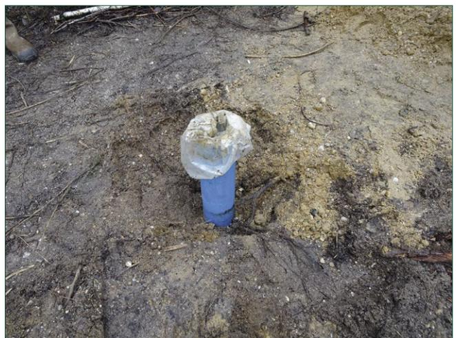
Abb. 13: Errichtung einer Güte-Grundwassermessstelle zur Überwachung einer Abfallverwertungsmaßnahme in einem Kiessandtagebau (links: ausgelegter Bohrkern, rechts: 5-Zoll-Ausbau noch ohne Überflerausbau und Abschlusskappe); (LfULG/ Grafe)
