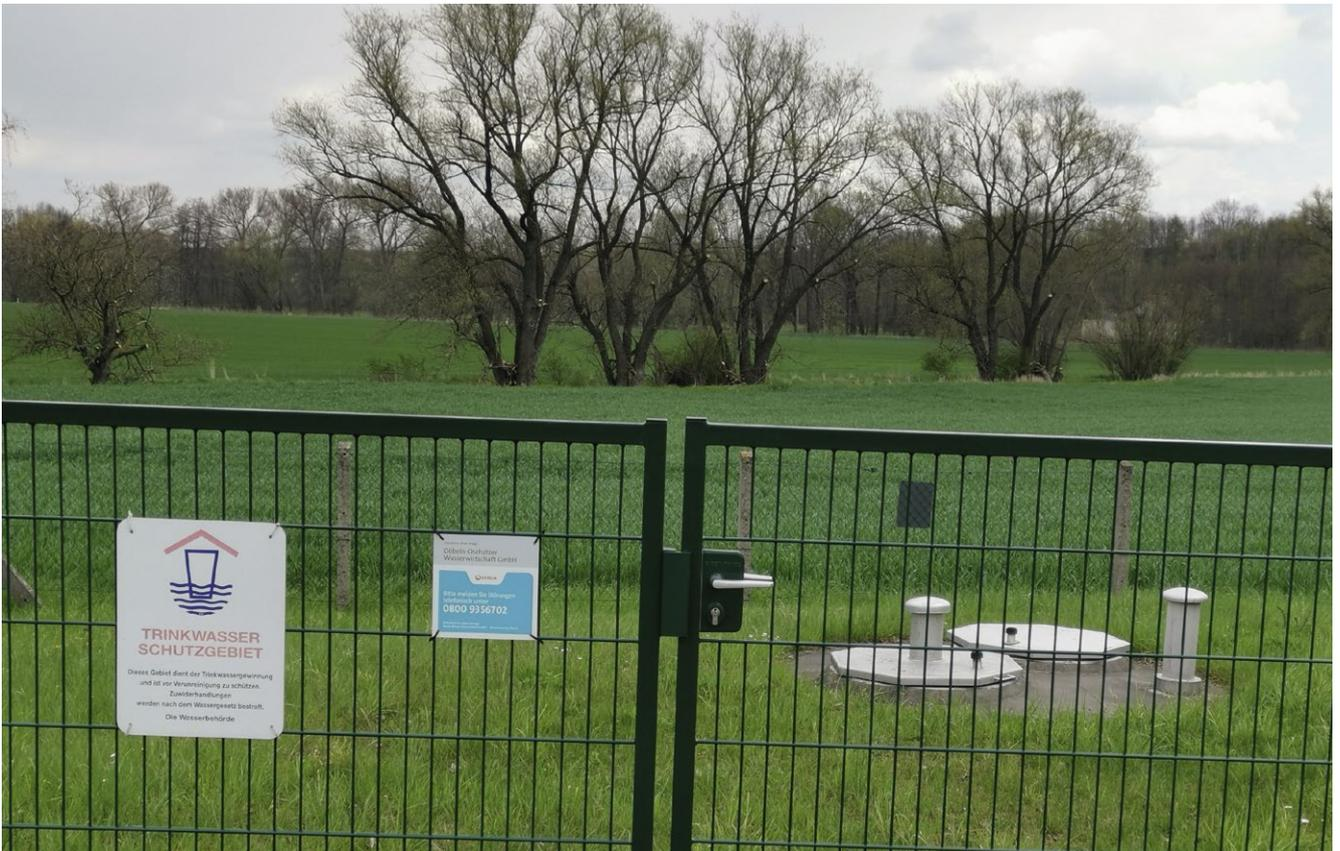
Abb. 5: Typische Trinkwasserschutzzone I einer Brunnenanlage mit Umzäunung (LfULG/ P. Fischer)
