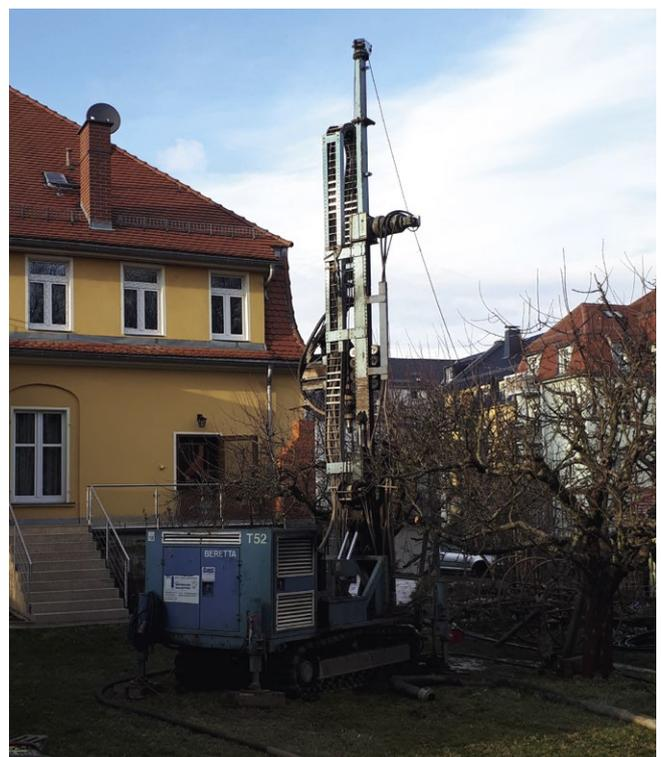
Abb. 4: Schema einer Erdwärmesondenanlage (links), Errichtung einer Erdwärmesondenbohrung (rechts), (LfULG)
