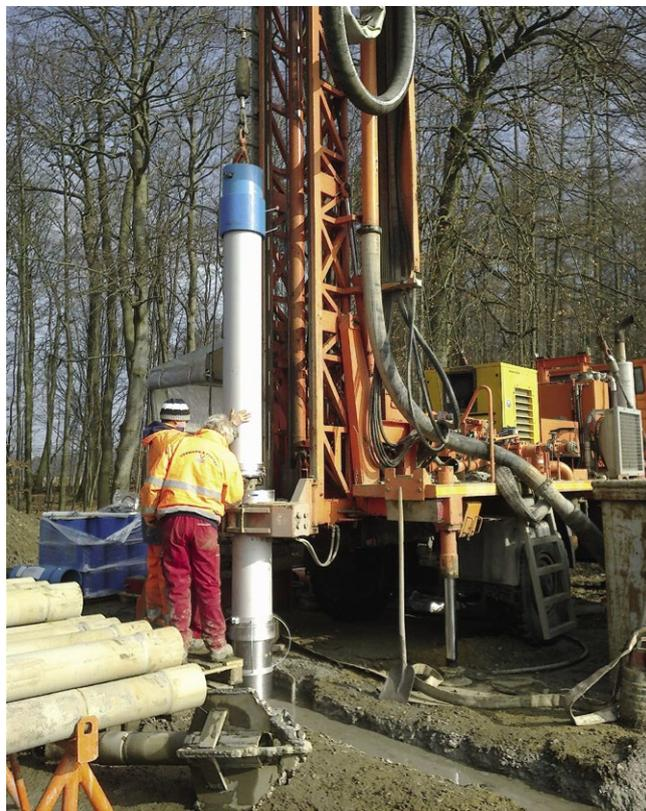
Abb. 17: Errichtung eines Brunnens zur Trinkwasserversorgung (LfULG/ M. Richter)
