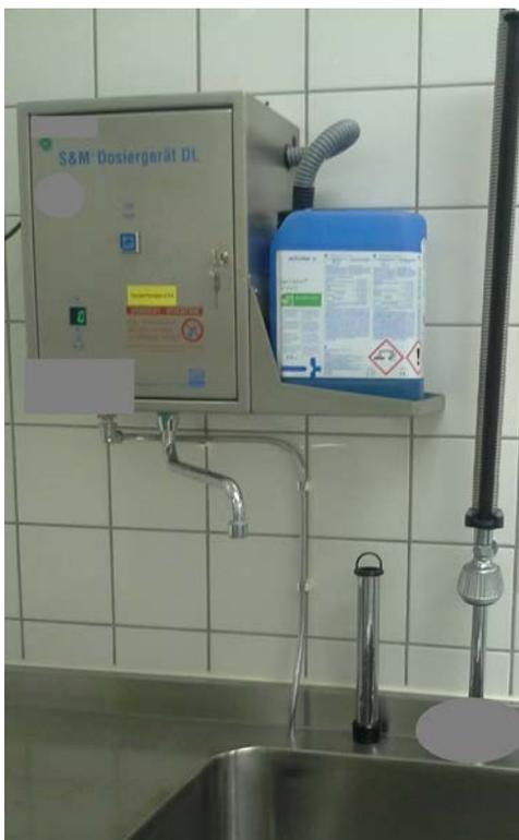
Abbildung 3: Desinfektionsmitteldosiergerät
