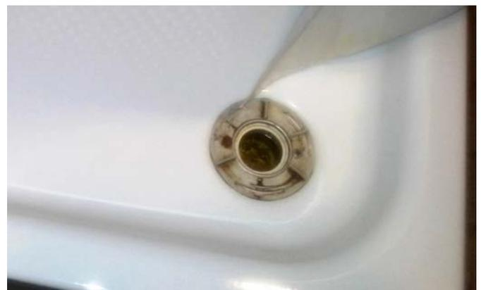
Abbildung 2: Mangelhafte Reinigung eines Duschablaufes (mit Stagnationswasser)
