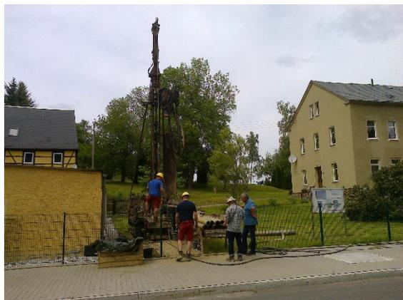
Abb. 10: Bohrarbeiten zum Bau der Grundwassermessstelle Sachsenburg
