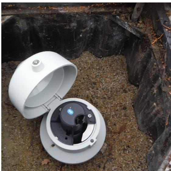
Abb. 8: Ausrüstung der Unterflurmessstelle Burgstädt mit DFÜ.
