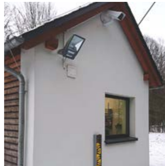
Abb. 2: Kamerabasierte Wasserstandserfassung am Pegel Lauenstein 4
