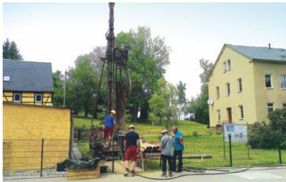
Abb. 6: Bohrarbeiten zum Bau der Grundwassermessstelle Sachsenburg
