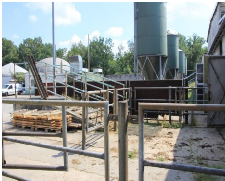
Abbildung 37: Verladeeinrichtung wurde umgenutzt als Lager
