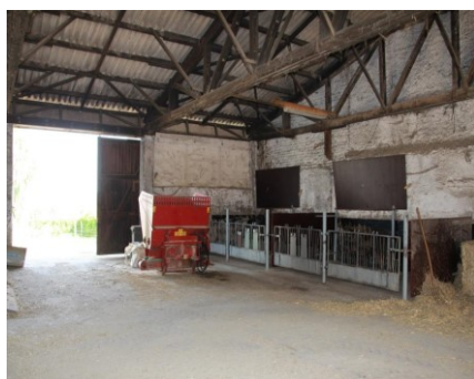
Abbildung 107: Gruppenbox für Kälberhaltung im Durchgangsbereich, mit Abdeckung für Mikroklima
