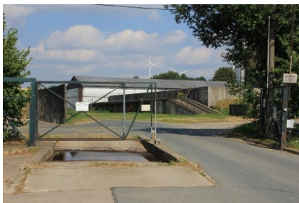
Abbildung 33: Beispiel für die Einzäunung und den Verschluss des Betriebes mit zu kurzer Desinfektionsdurchfahrwanne
