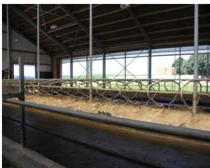
Abbildung 73: Tiefbox, sehr gut gepflegt
