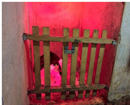
Abbildung 120: Kälberbox mit Holztür, Problem bei der Desinfektion
