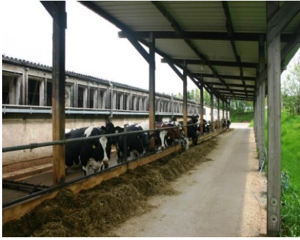
Abbildung 81: Auslauf mit Betonfußboden, per Schieber gereinigt
