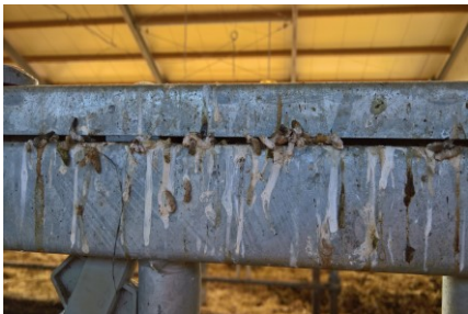
Abbildung 167: Mit Vogelkot verunreinigte Stallausrüstung
