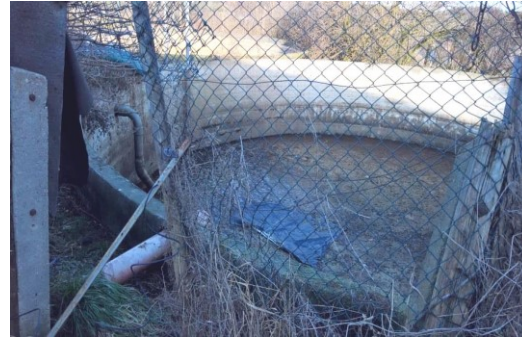
Abbildung 159: Güllelagerung nicht vollständig abgeschlossen
