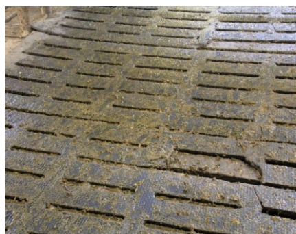
Abbildung 69: Defekte Stellen im Spaltenboden
