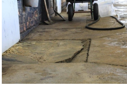
Abbildung 21: Fußboden im Stall
