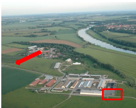
Abbildung 152: Kadaverhaus (rotes Kästchen) Lage an einer Straße, Hauptzufahrt durch Pfeil
