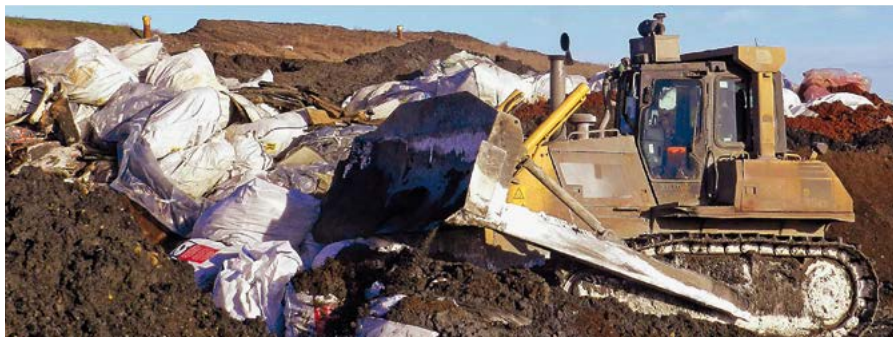
2.5.1 / Abb. 1: Überdeckung lose verpackter KMF-haltiger Abfälle auf der Deponie (Quelle: Abfallbrief der Westsächsischen Entsorgungs- und Verwertungsgesellschaft mbH vom April 2014)
