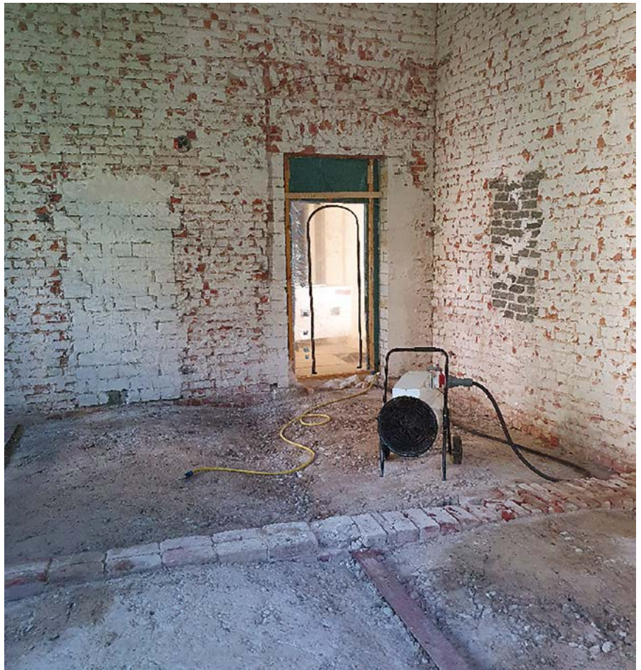
2.5.2 / Abb. 2: Abgeschotteter Raum zur Durchführung des Ausbackverfahrens mittels Wassernebel und Elektroheizlüfter
