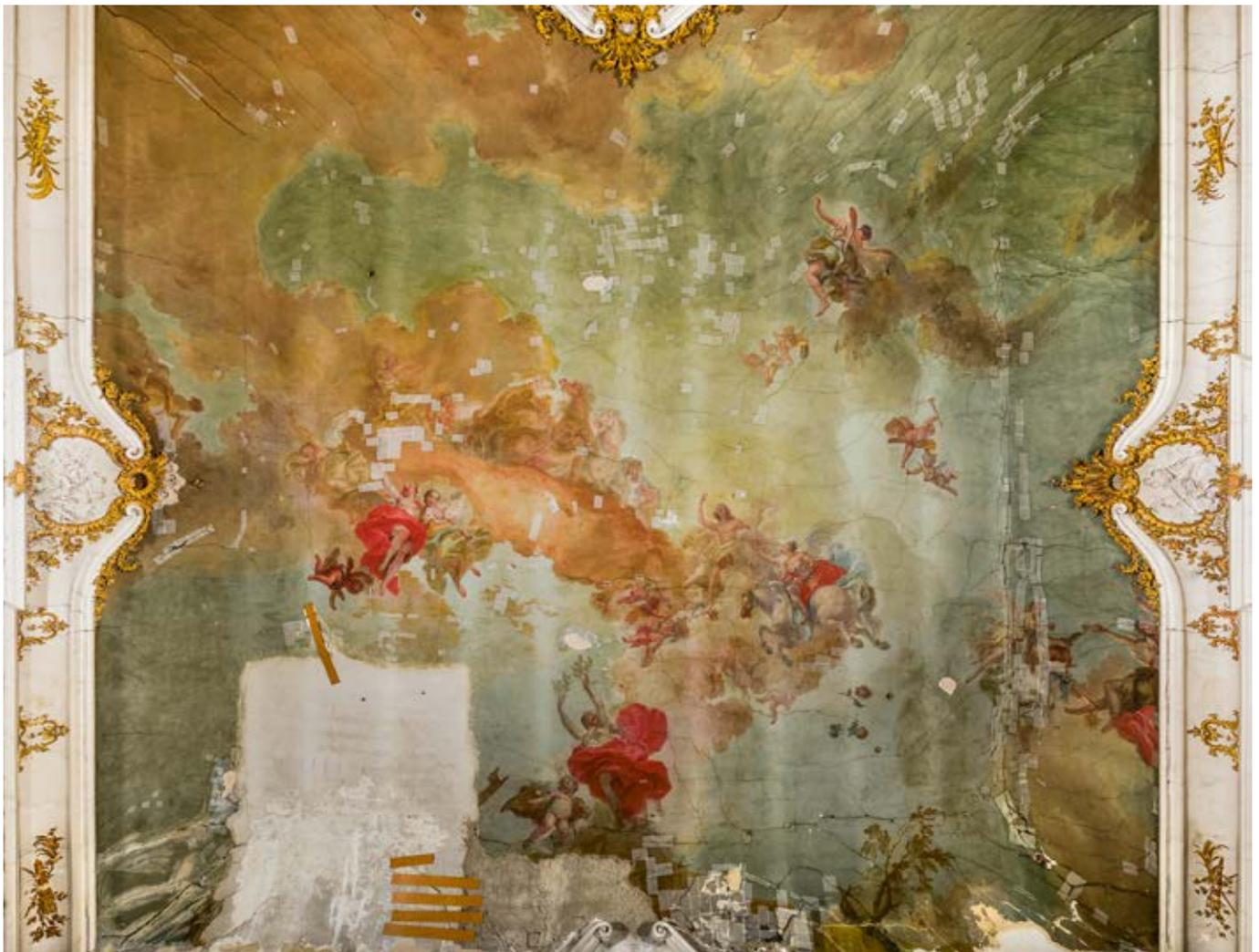
Nischwitz, Schloss, hier: Deckengemälde im Festsaal, aktueller Zustand mit Rissen im Putz, Verluste im Putz durch Wasserschaden, partielle Sicherungsbeklebung in gefährdeten Malschichtbereichen, 2022
