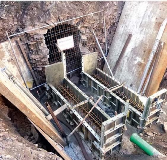
oben: Anbindung der Entwässerung vom Johannes Stolln, rechts: Stollensicherung mit Stahlausbau
