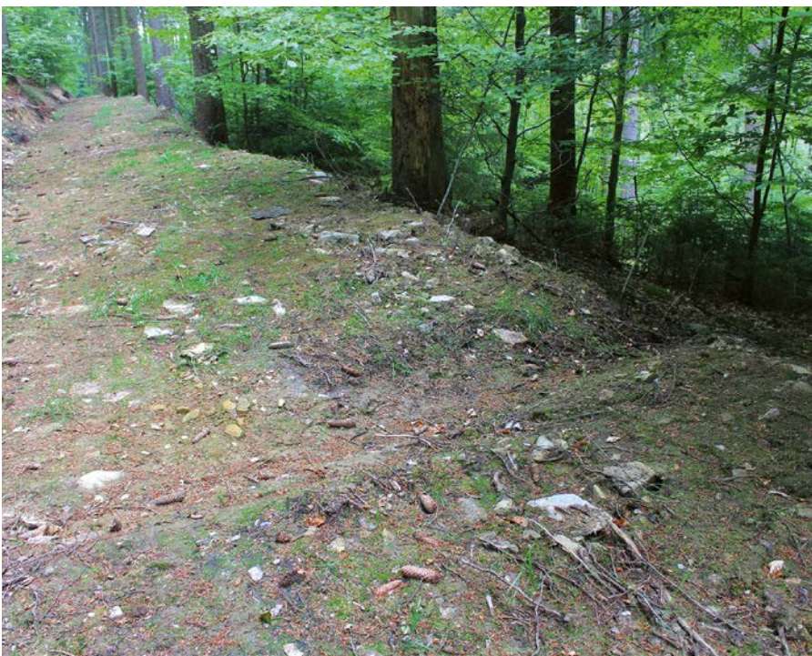
Abb. 4: Muldenförmiger Querabschlag zur Wasserableitung; Foto: Mirjam Oeser
