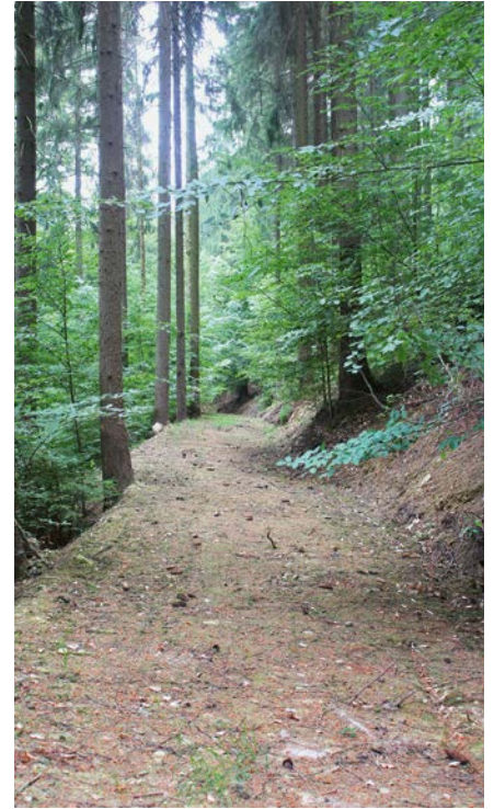
Abb. 3: Die Querneigung der Fahrbahn ist auf dem ersten Blick erkennbar; Foto: Mirjam Oeser
