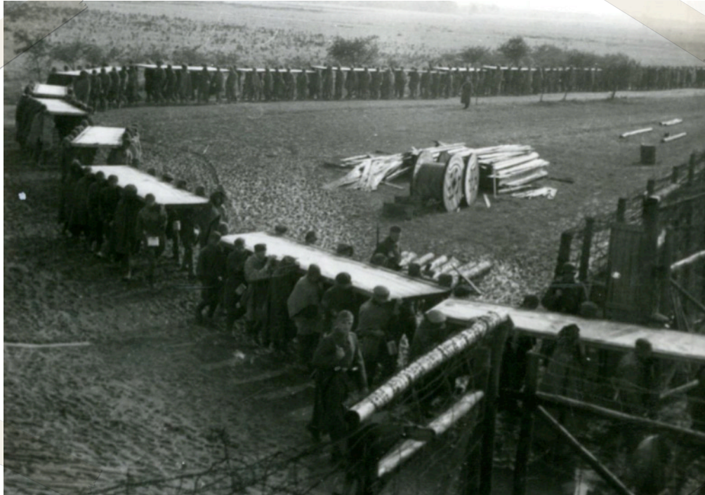
Bild 9: Errichtung des Kriegsgefangenenlagers Zeithain
