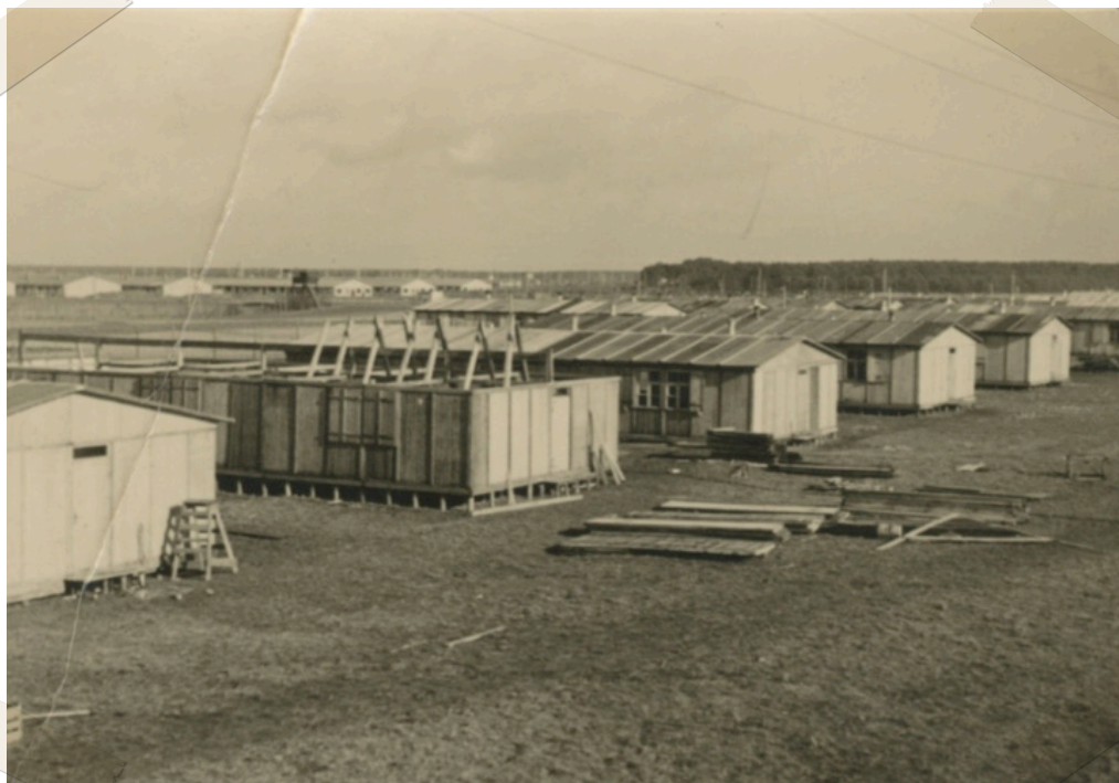
Bild 10: Errichtung des Kriegsgefangenenlagers Zeithain
