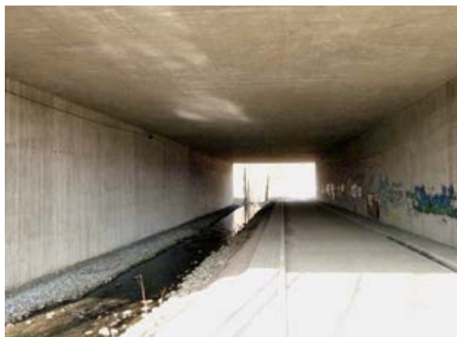
Abb. 31: Gewässerunterführung (> 2 m) mit Randstreifen und Straße an der A40st
