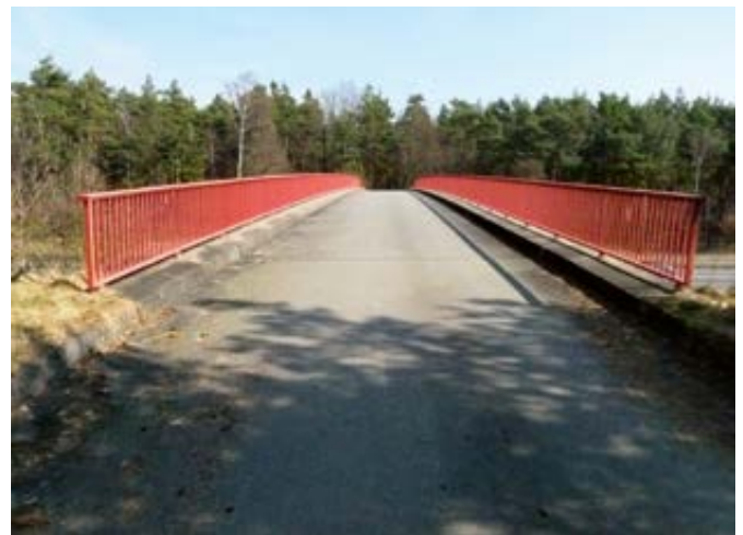
Abb. 28: Waldwegüberführung an der A13
