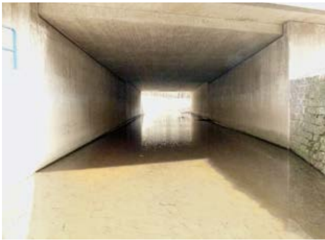
Abb. 32: Gewässerunterführung (> 2 m) ohne Randstreifen an der A13
