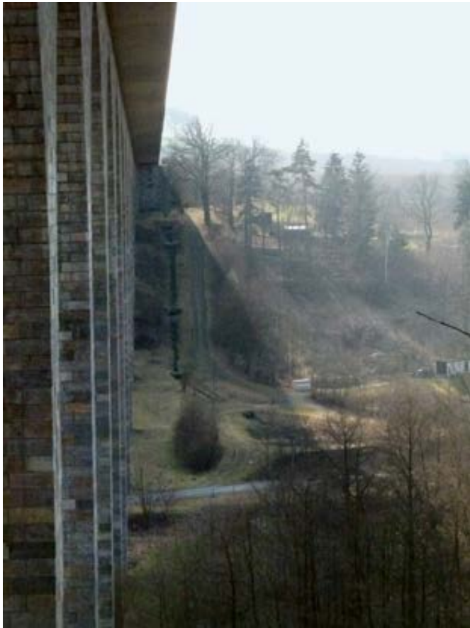
Abb. 26: Großbrückenunterführung an der A 72
