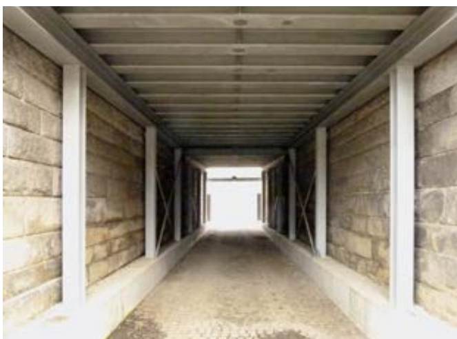
Abb. 35: Feldwegunterführung an der A13
