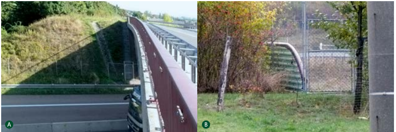
Abb. 52: Zauanbindung an Überführungen mit schlechter (A) und guter (B) Leitwirkung für größere Wildtiere
