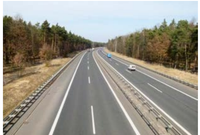
Abb. 1: Blick auf die gezäunte und mit Leitplanken versehene Autobahn A13 im Freistaat Sachsen
