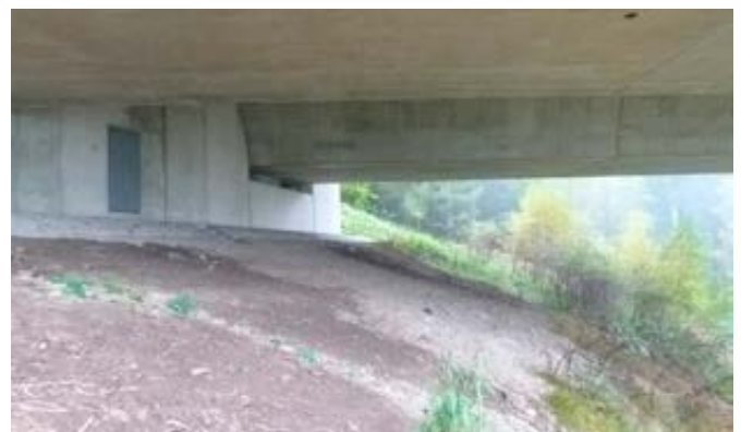
Abb. 8: Der Rotwildhauptwechsel lag direkt am Brückenkopf der Talbrücke.
