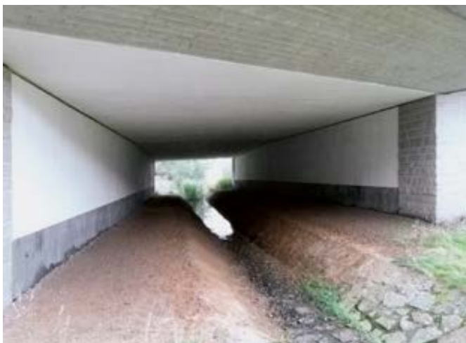
Abb. 56: Intensiv durch Schalenwild genutzte Gewässerunterführung mit Randstreifen
