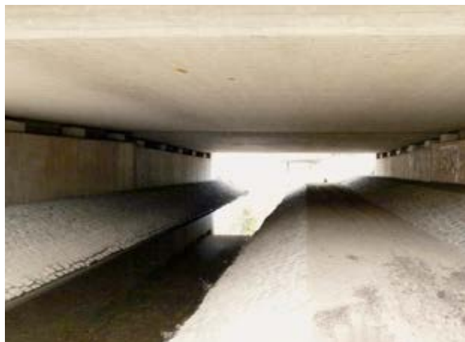
Abb. 30: Gewässerunterführung (> 2 m) mit breitem Randstreifen an der A13
