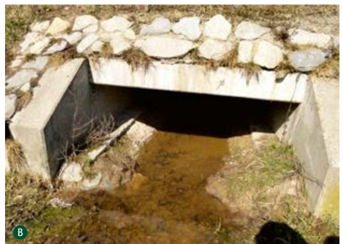
Abb. 55: Gewässerdurchlass ohne (A) und mit (B) Randstreifen
