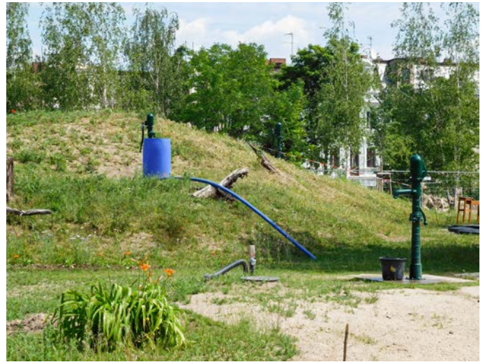
Wasserspiel – Wasser- pumpe angeschlossen an einer Zisterne
