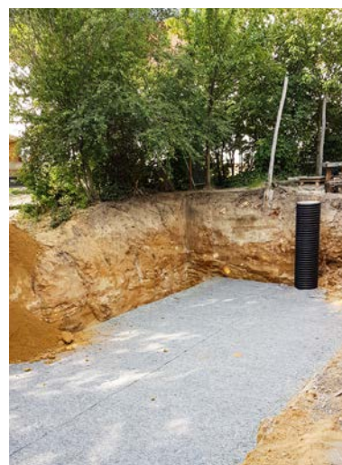
Herstellung der Baugrube
