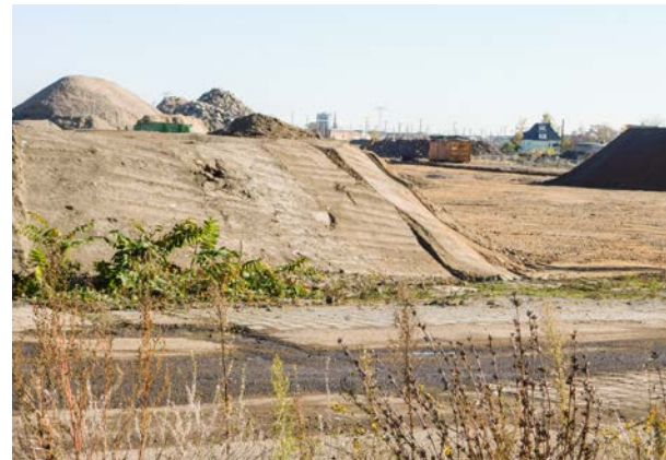
Baustelle Eutritzscher Bahnhof
