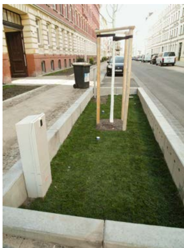
Fertiggestellte Baumrigolen mit temporärer Grasunterpflanzung (links)
