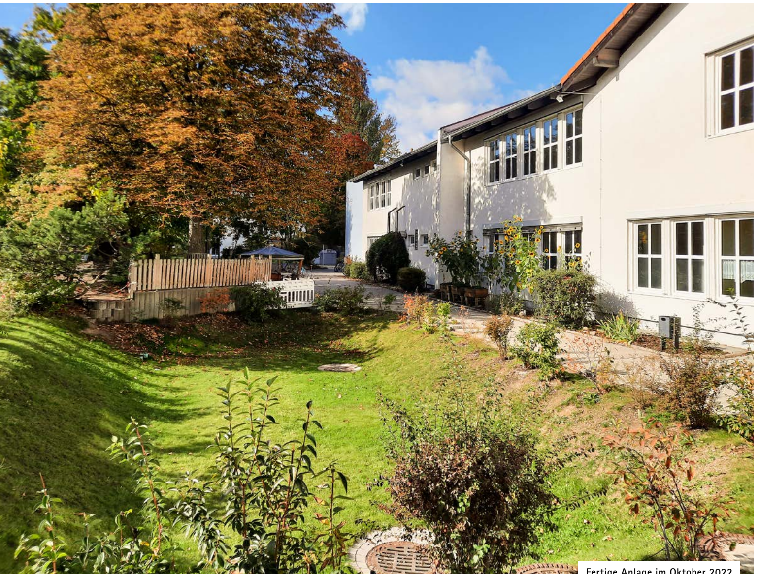
Fertige Anlage im Oktober 2022
