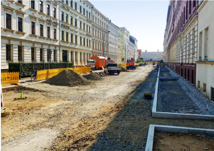
Bauarbeiten zur Herstellung der Baumrigolen
