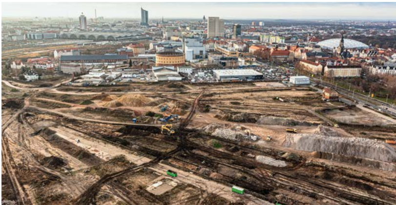
Übersicht der Baustelle Eutritzscher Bahnhof in Leipzig vor der Revitalisierung
