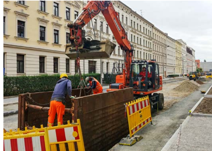
Bauarbeiten zur Herstellung der Baumrigolen
