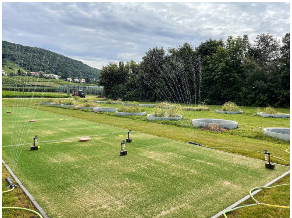
Versuchsaufbau Sportplätze als Sickeranlagen
