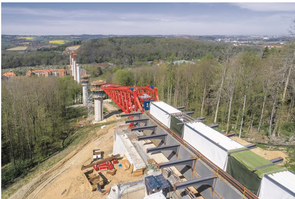
Bild 15 B 172n OU Pirna Gottleubatalbrücke nach Teilvershub Stahlüberbau (© René Legrand)
