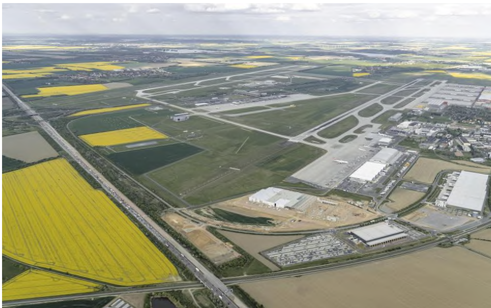
Bild 30 Luftbild Airport Leipzig/ Halle Mai 2022 (© Uwe Schoßig / MFAG)
