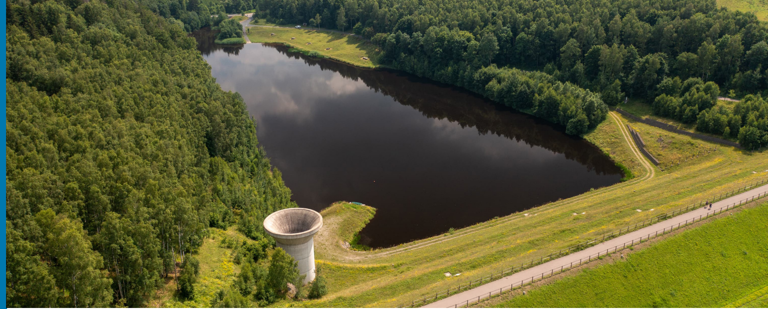
Der markante Trichter ist der Hochwasserüberfall des Beckens
