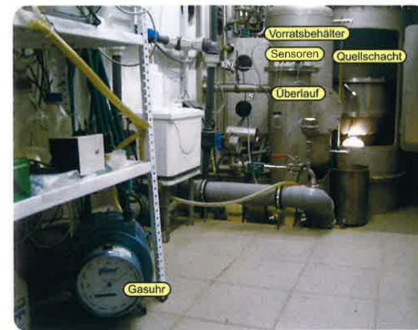
**Abb. 32:** Wetzinquelle Bad Brambach: Fassungskeller mit Quellschacht, Vorratsbehälter, Gasuhr, hydraulischen und hydrochemischen Sensoren am Überlauf
