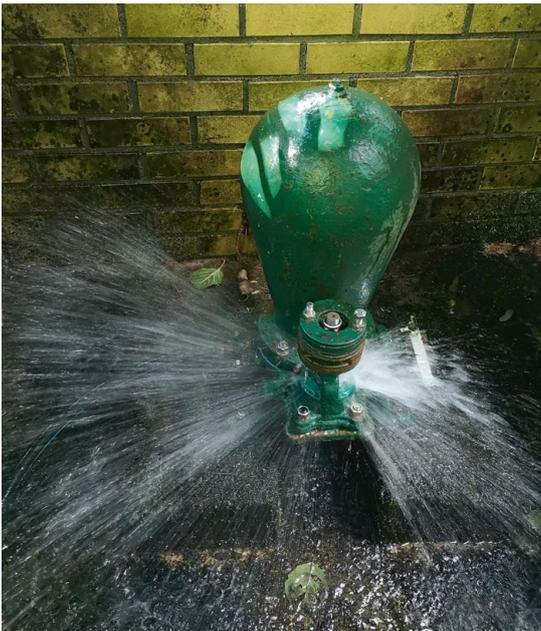
Der hydraulische Widder im Dauerbetrieb
