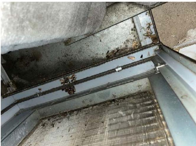
Abbildung 13: Verschmutzung und Insektenüberreste im Bereich eines Heizregisters nach erster Filterstufe
