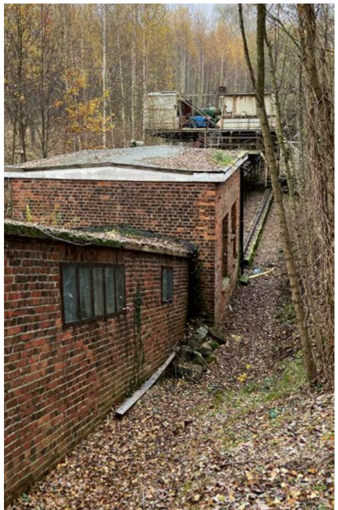
Schrägbandbrücke mit Schöpfergerät und Grabenbunker
