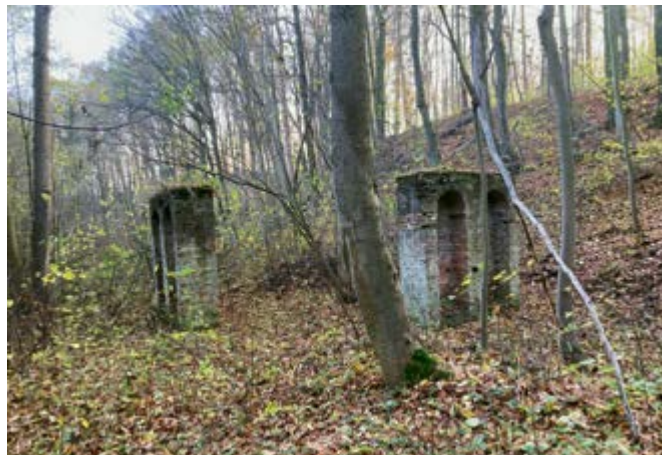
Reste einer Rohrbrücke
