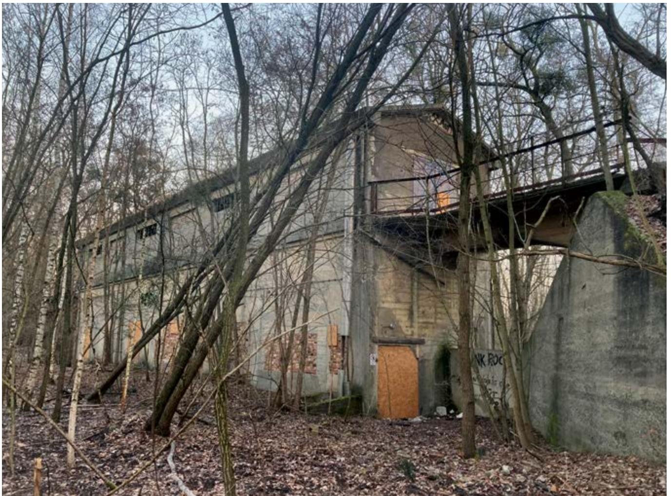
Gesamtansicht von Süden
