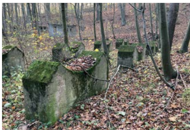
Betonaufleger der Lagertanks
