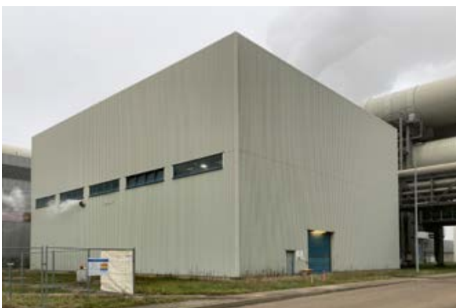
Fernwärmeübergabestation auf dem Gelände des Kraftwerks Boxberg
