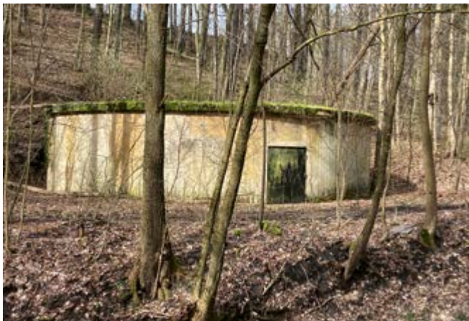
Ansicht eines der sechs Stahlbetonbehälter
