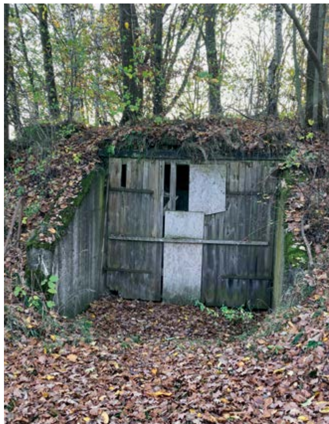
Zugang zum Lagerkeller
