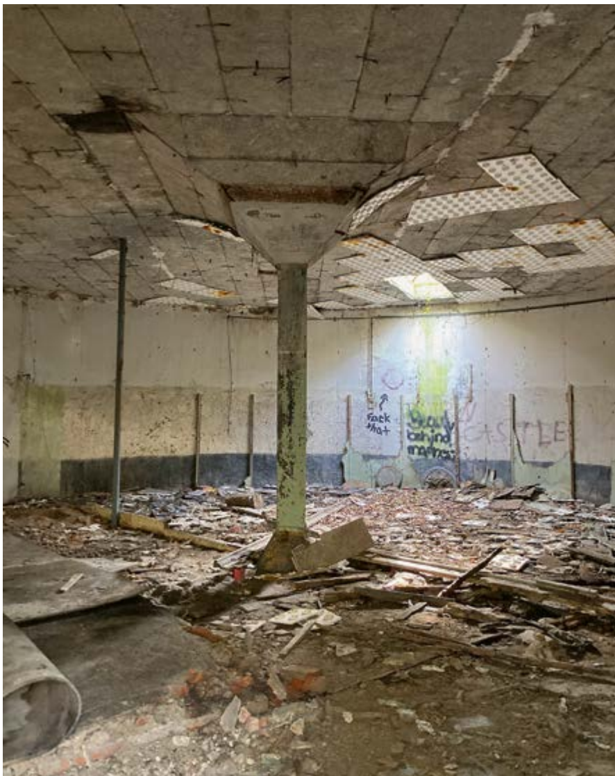
Innenansicht eines Stahlbetonbehälters mit Pilzkopfstütze
