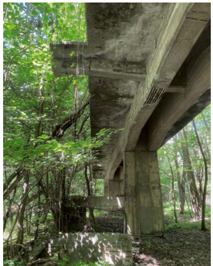
Detail der Stahlbetonbalkenbrücke
