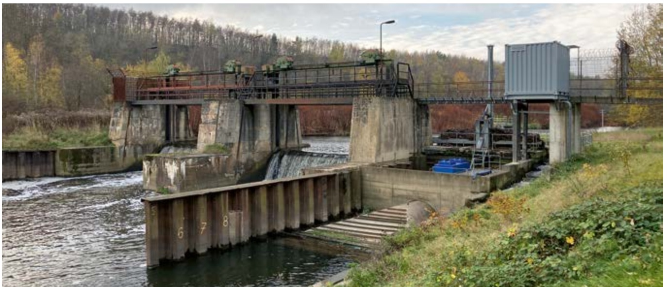
Gießmannsdorfer Wehr an der Neißer
