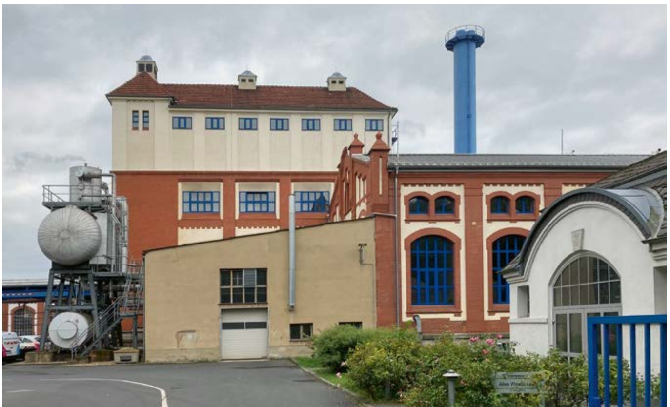
Hauptgebäude mit Kesselhaus und Maschinenhaus
