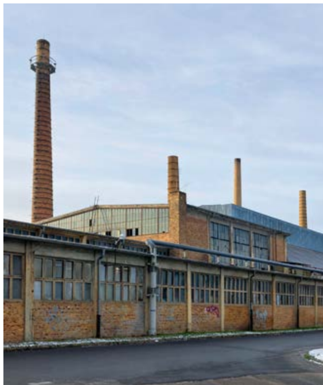
Ofengebäude an der Straße der Einheit
