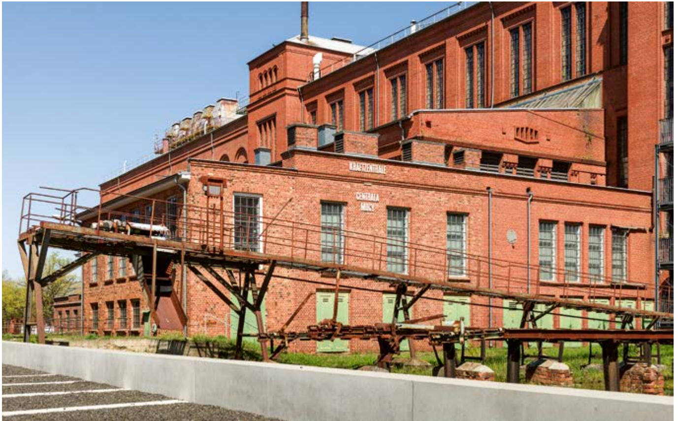
Gesamtansicht der Kraftzentrale von Süd-West
