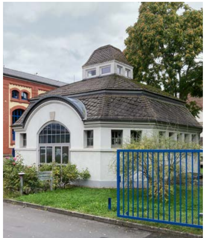
Altes Wasserhaus für die Reinigung von Mandauwasser zur Turbinenkühlung
