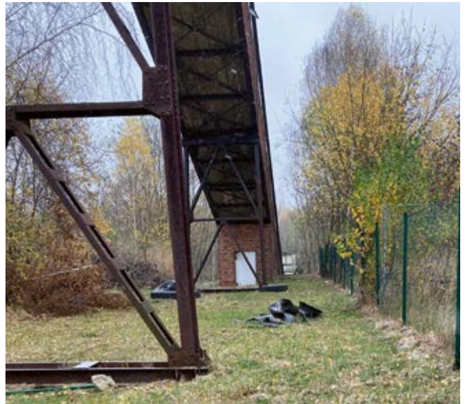
Schrägbandbrücke vom Grabenbunker zum Siebgebäude
