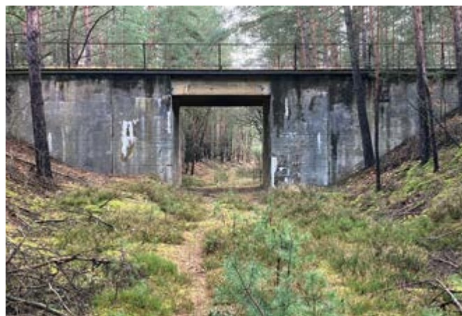
Brücke über die frühere Kohlebahn Knappenrode-Welzow bei Weißkollm
