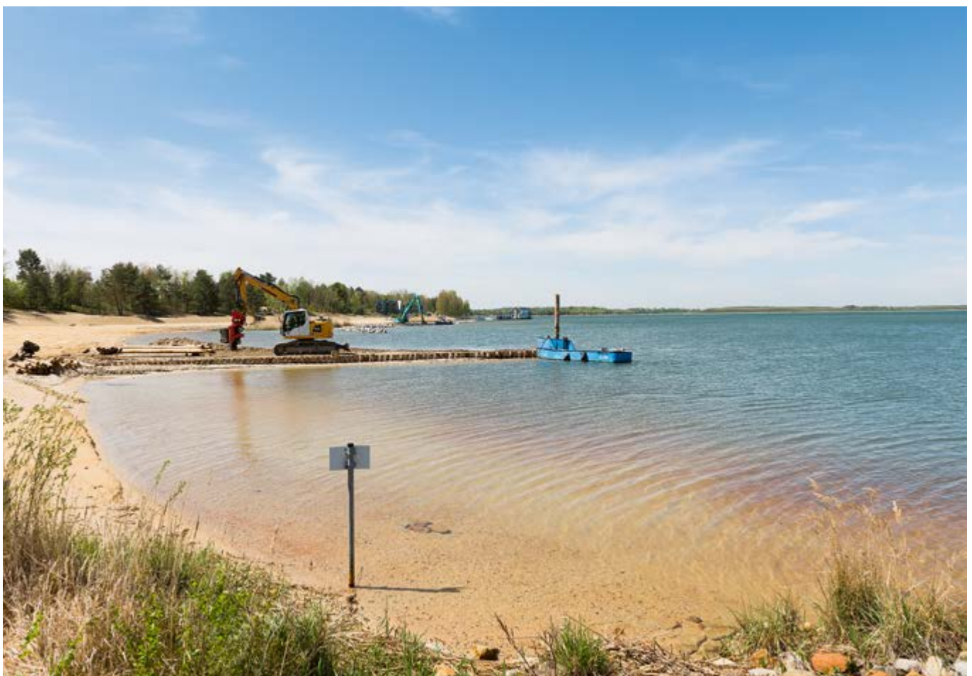
Neubefestigung eines Strandabschnittes
