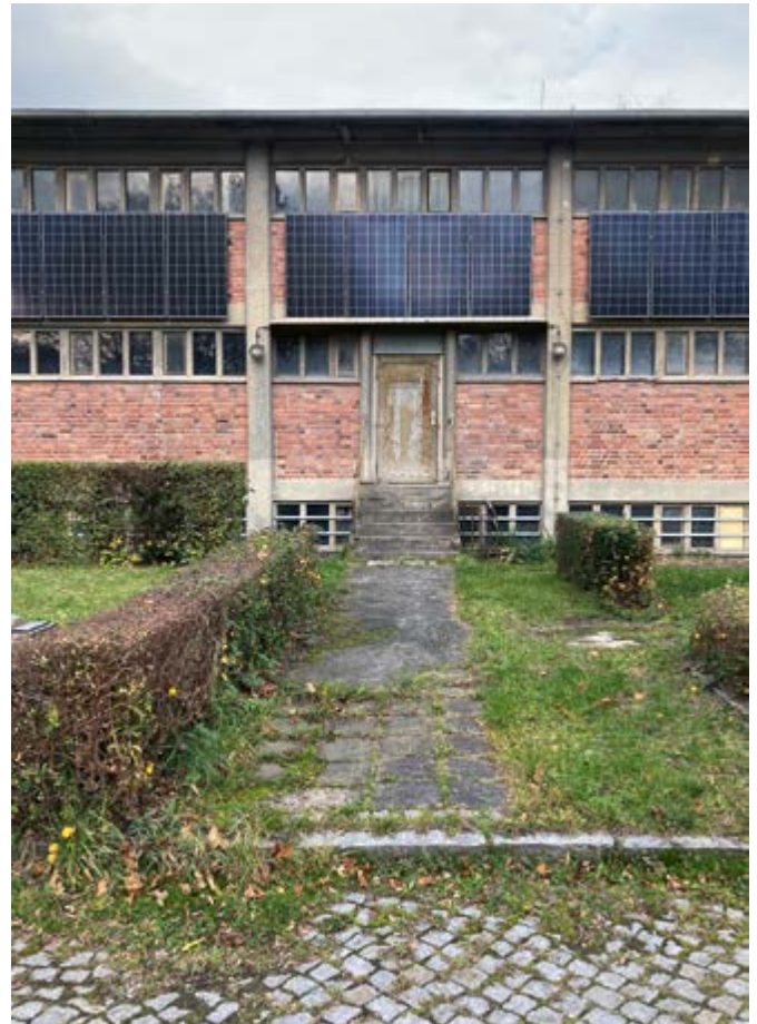
Ehemaliges Hauptlager aus der Zeit um 1950
