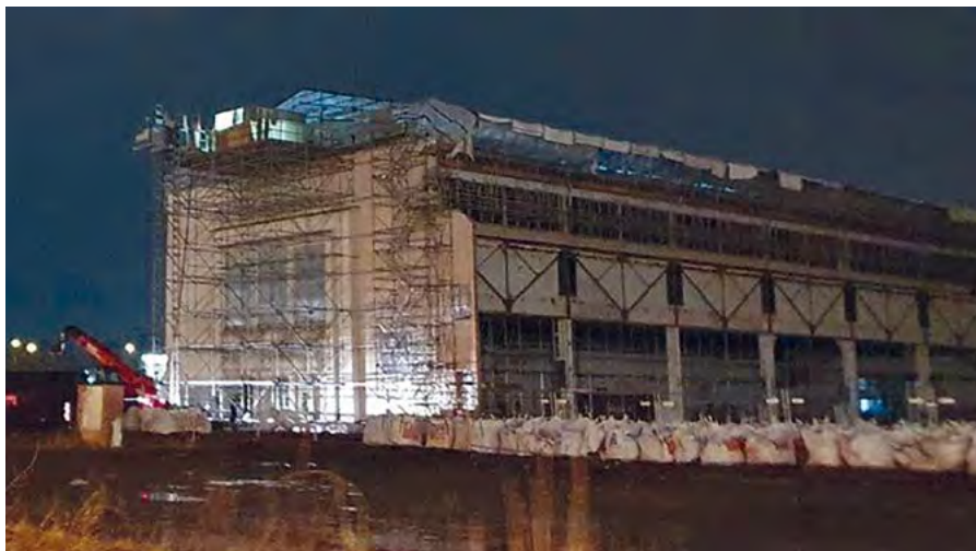
2.4.1 / Abb. 5: Kontrolle bei Nacht
