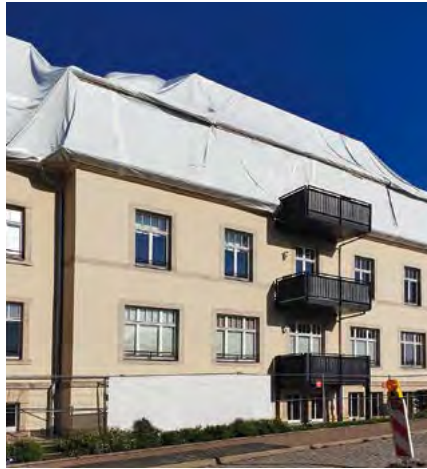
2.4.3 / Abb. 1: Ehemalige Hutfabrik Bannewitz mit abgedichtetem Dach
