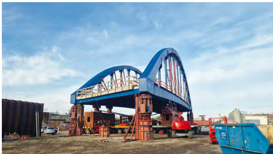
2.2.2 / Abb. 1: Brückenbauwerk BW70 vor dem Einschwenken
