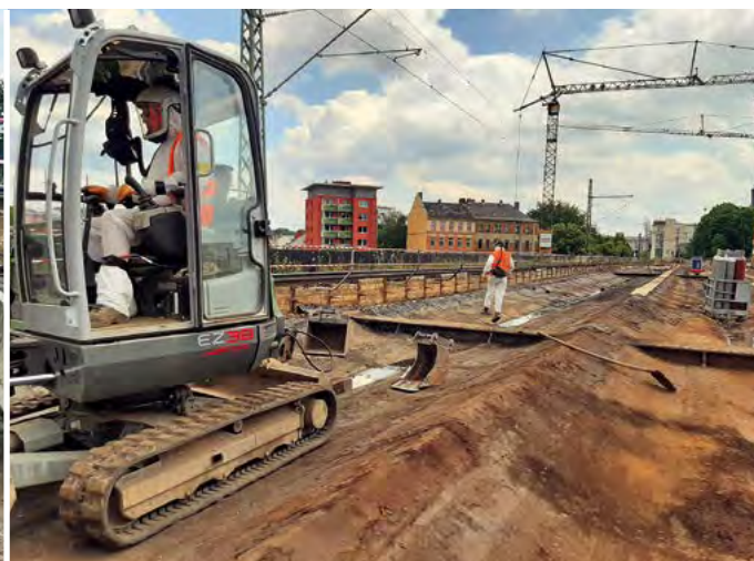
2.4.2 / Abb. 3: Umgesetzte Schutzmaßnahmen, Nachkontrolle
