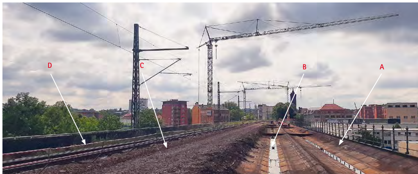
2.4.2. / Abb. 1: Baustellenkontrolle des Viadukts am 10. Juni 2022: die Gleise D bis A (v. l.)
