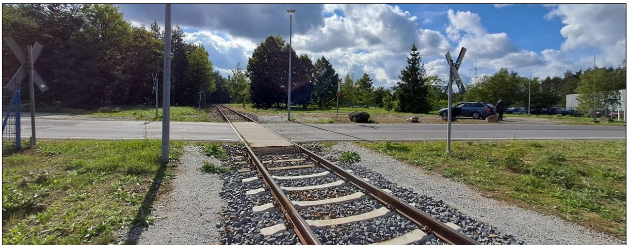
Abbildung 31: Bahnübergang L581 Schwarzbacher Str., Hosena i. Ri. Quartzwerke GmbH
